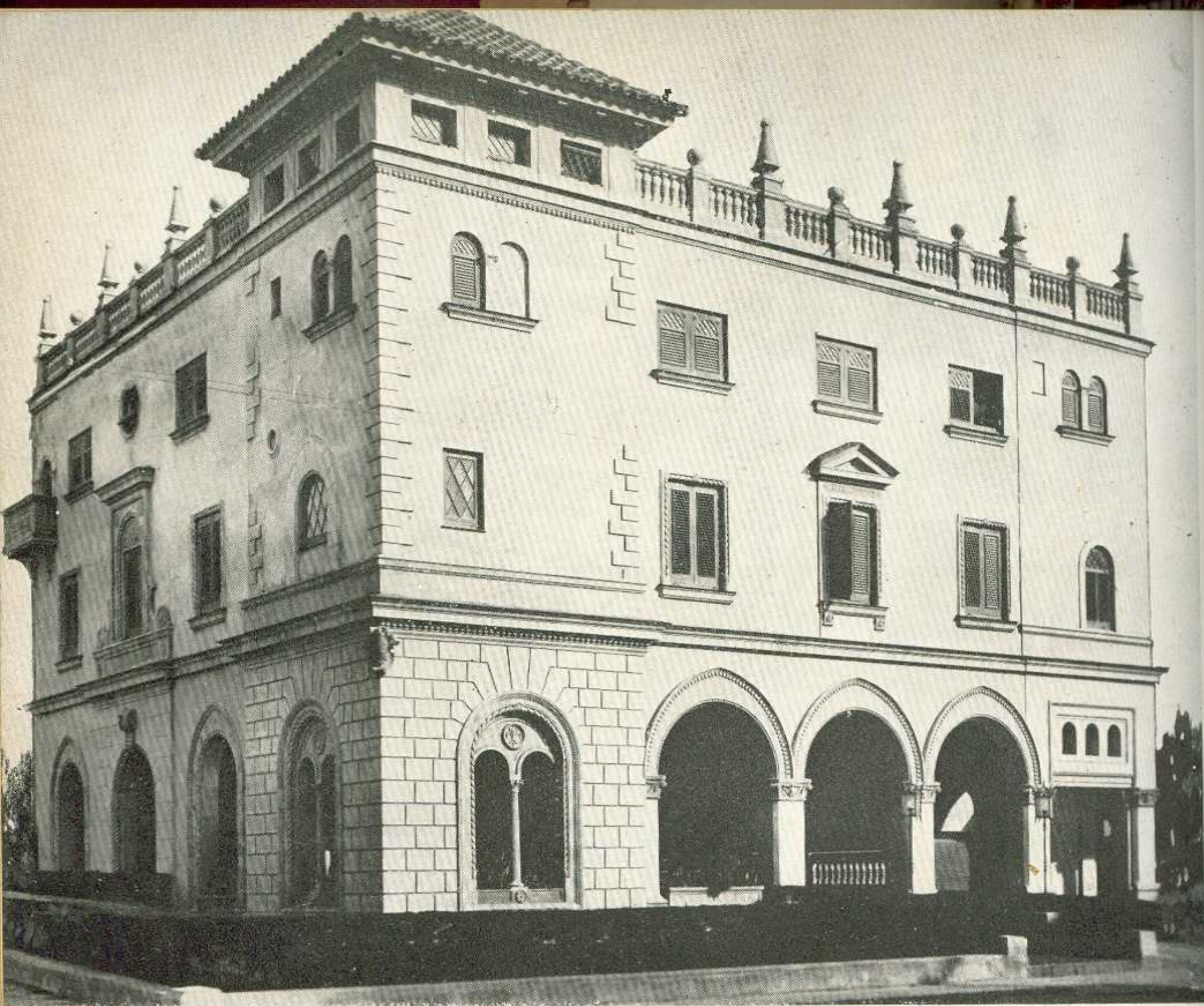
Vista general del edificio de J y 25, Vedado. Estilo florentino de mil quinientos. Nótese que con un simple resalto en planta baja y con las cadenas de piedra se ha logrado representar el macizo de una torre de esquina, que arranca del piso con aparente base cuadrada. El muro recortado de pinos cubre este arranque de la torre, deformando aparentemente los elementos arquitectónicos del basamento. Primer Premio. César Guerra, arquitecto. M. Contretas, propietario
