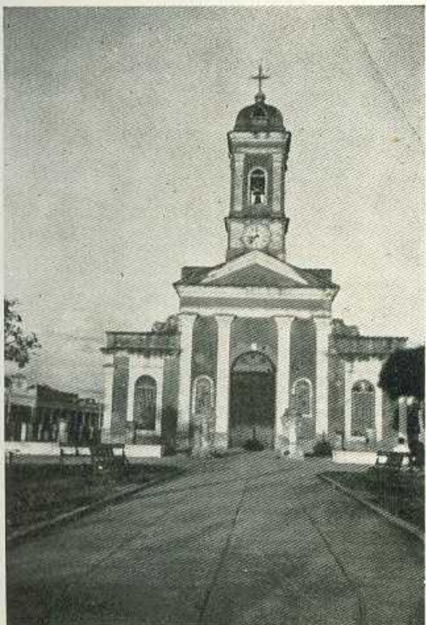
Iglesia de Consolación del Sur
