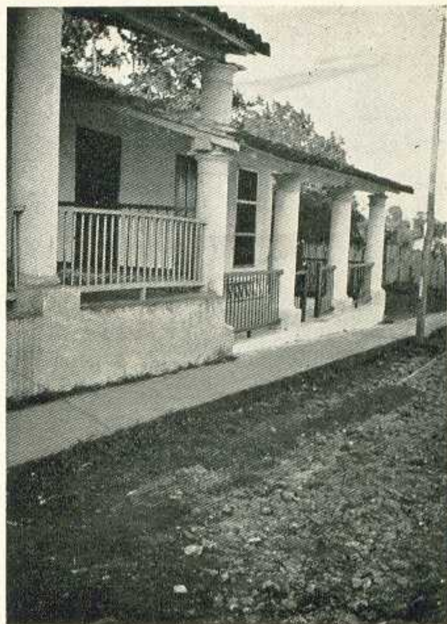
Anomalia arquitectónica en una de las columnas. Viñales. Pinar del Río
