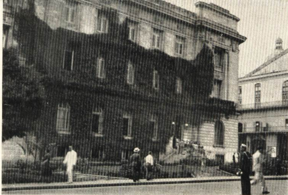
Fachada lateral del edificio del Instituto Provincial
