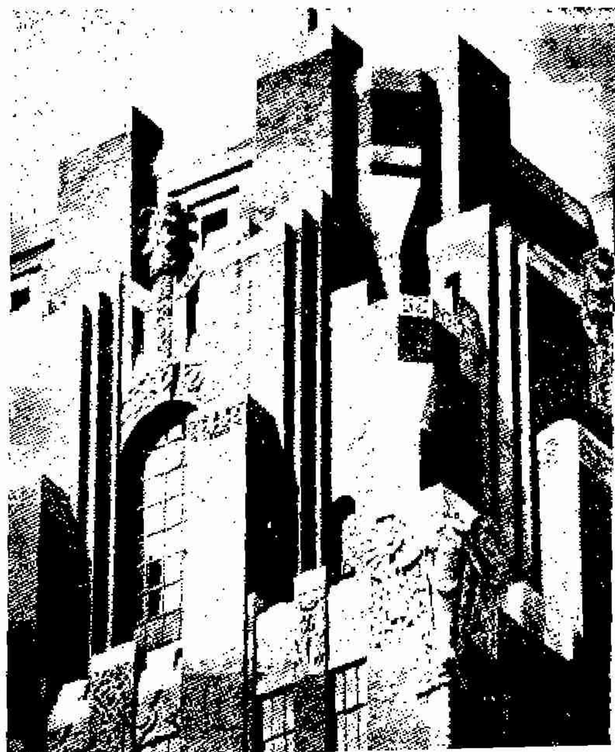
Detalles superiores del New York Telephone B.—Walker, Arquitecto.
