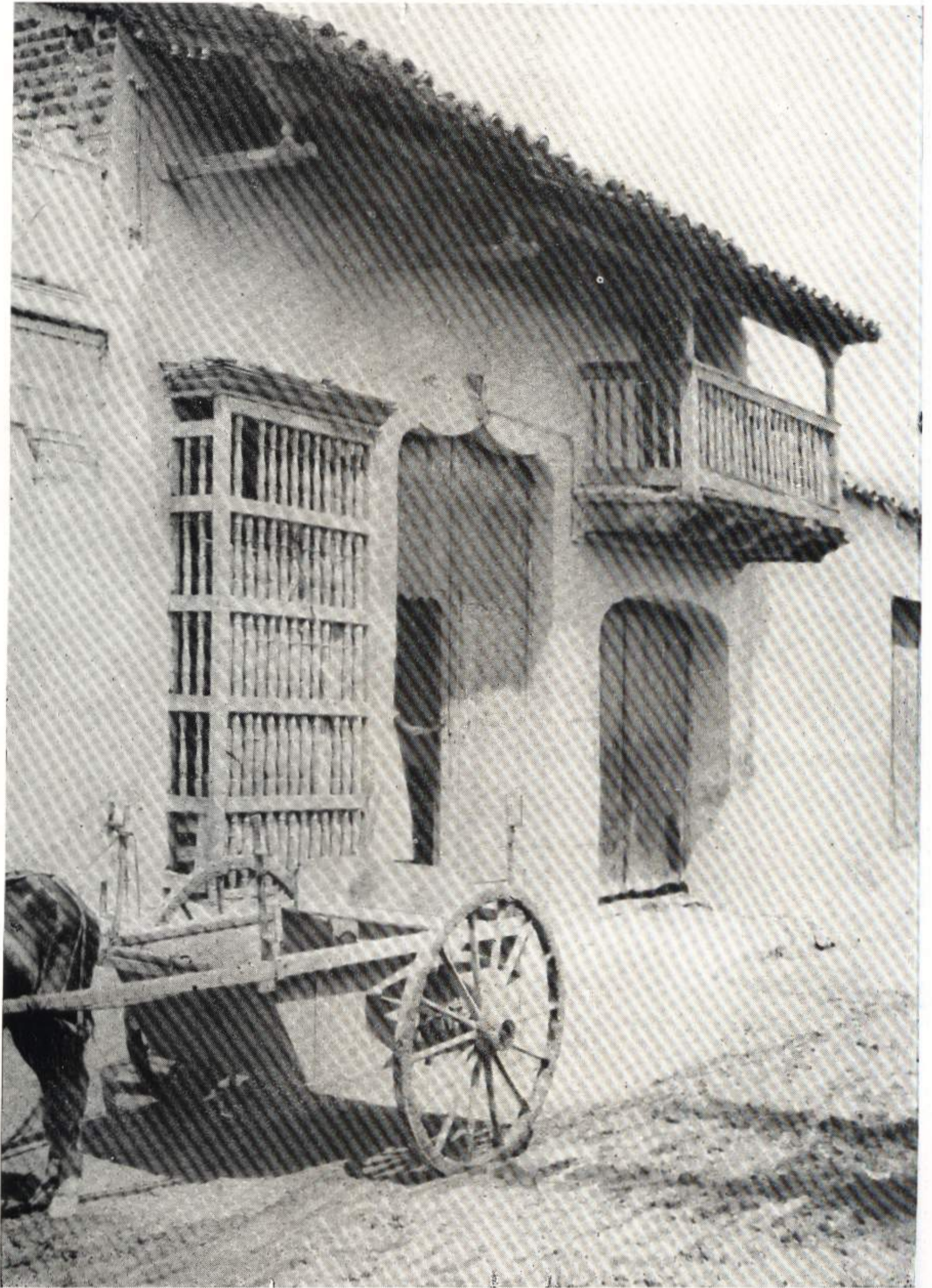
Antigua casa en Camagüey
