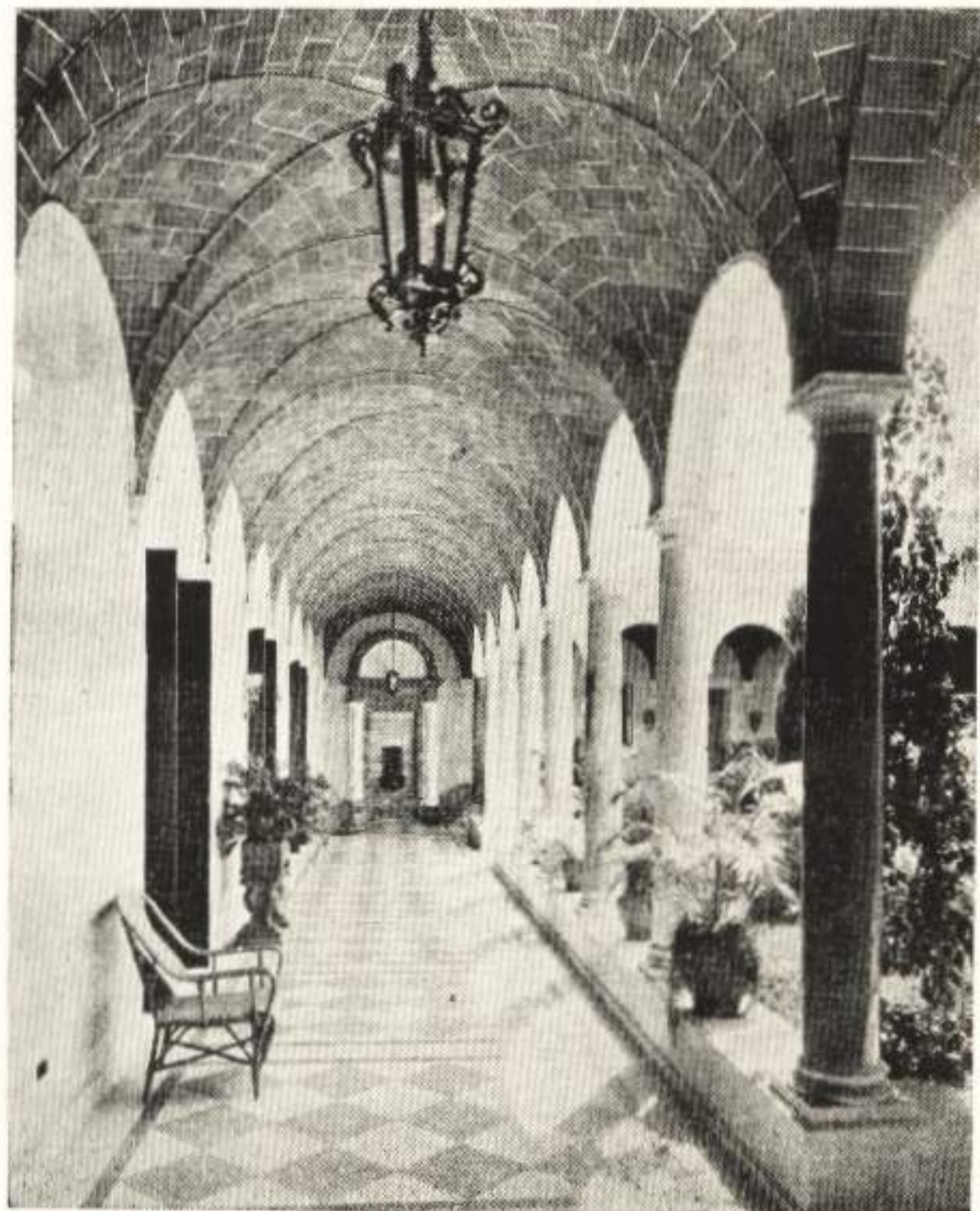
Galería del patio
