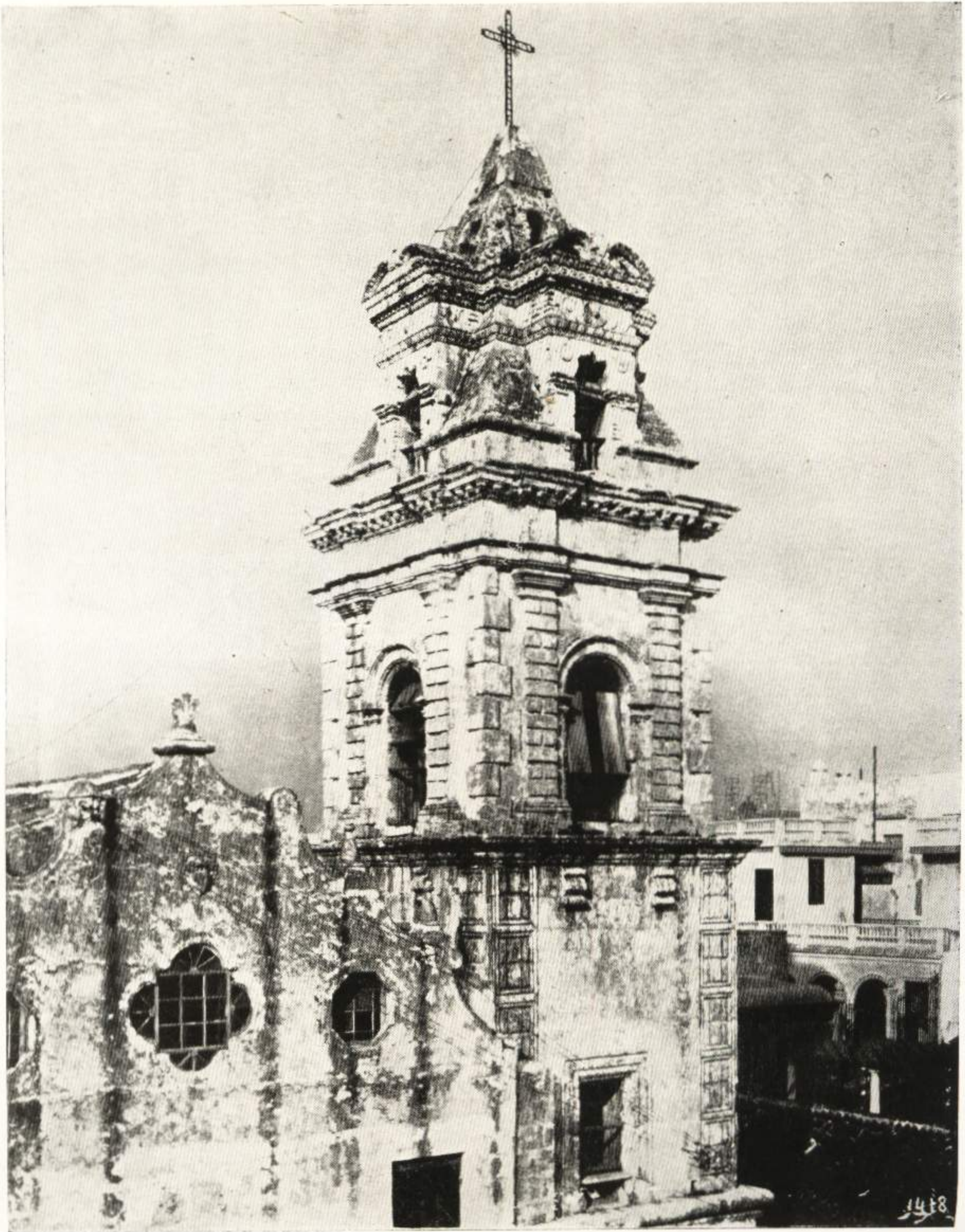
Antigua torre de San Francisco, antes de la restauración.
