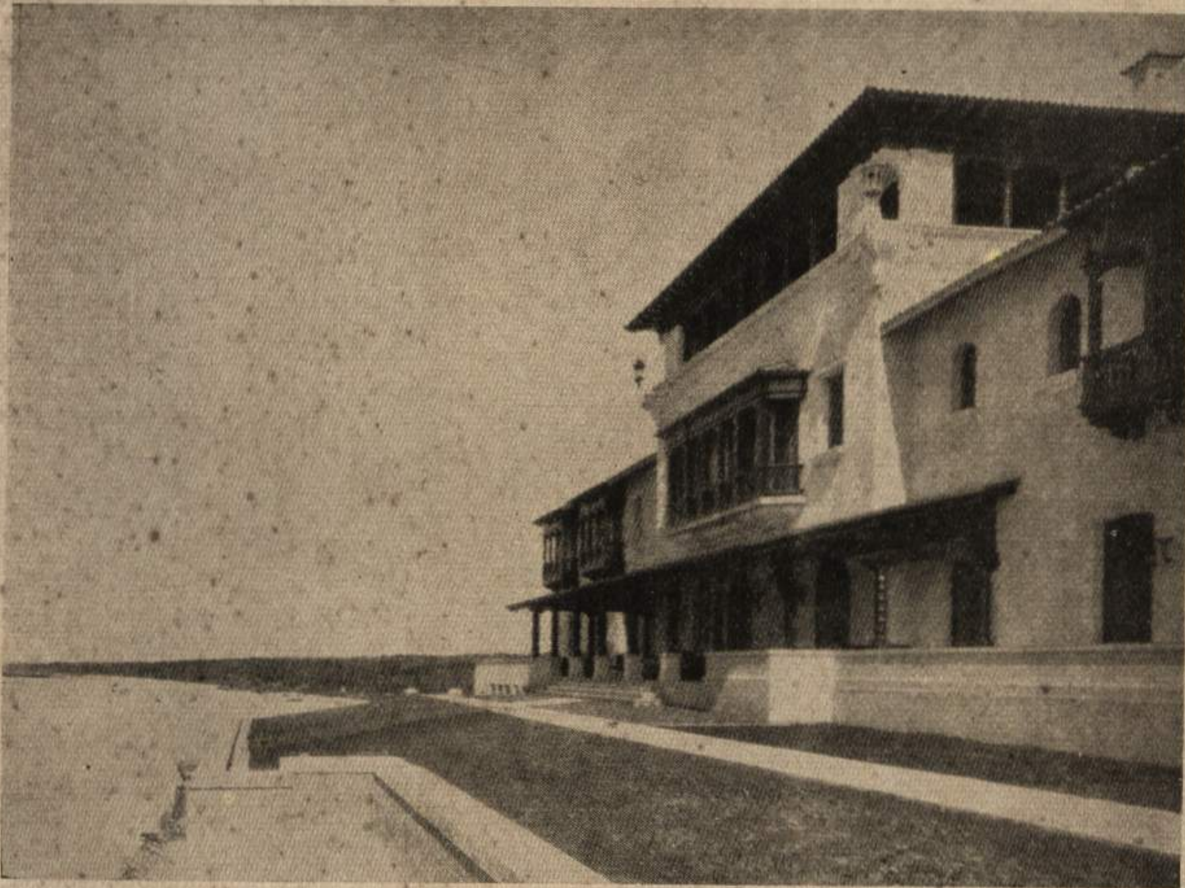
Residencia del Sr. du Pont.—Fachada.—Govantes y Cabarrocas, Arq. Frederick Snare Corporation, Contratistas.
