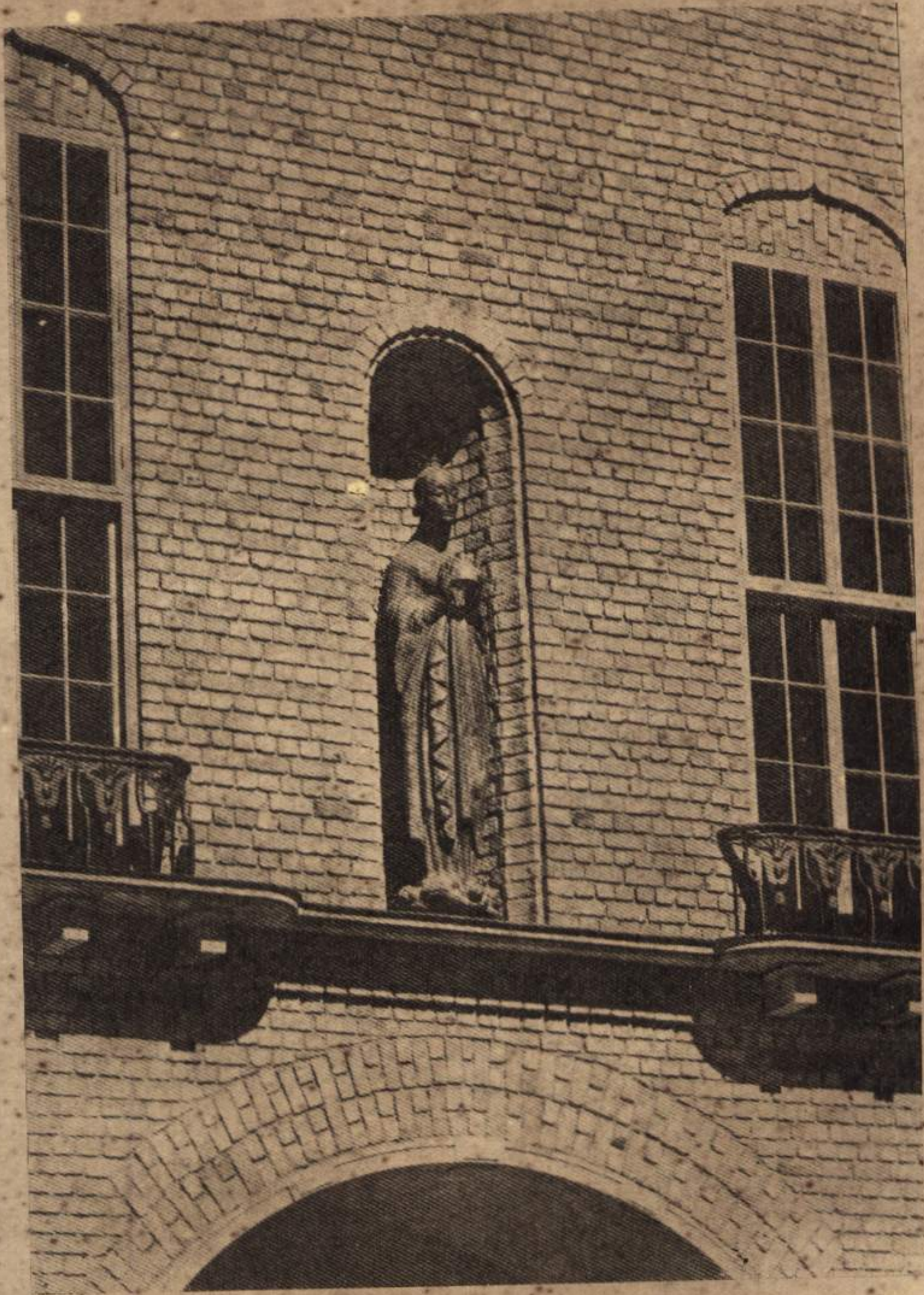
Detalle de fachada.
