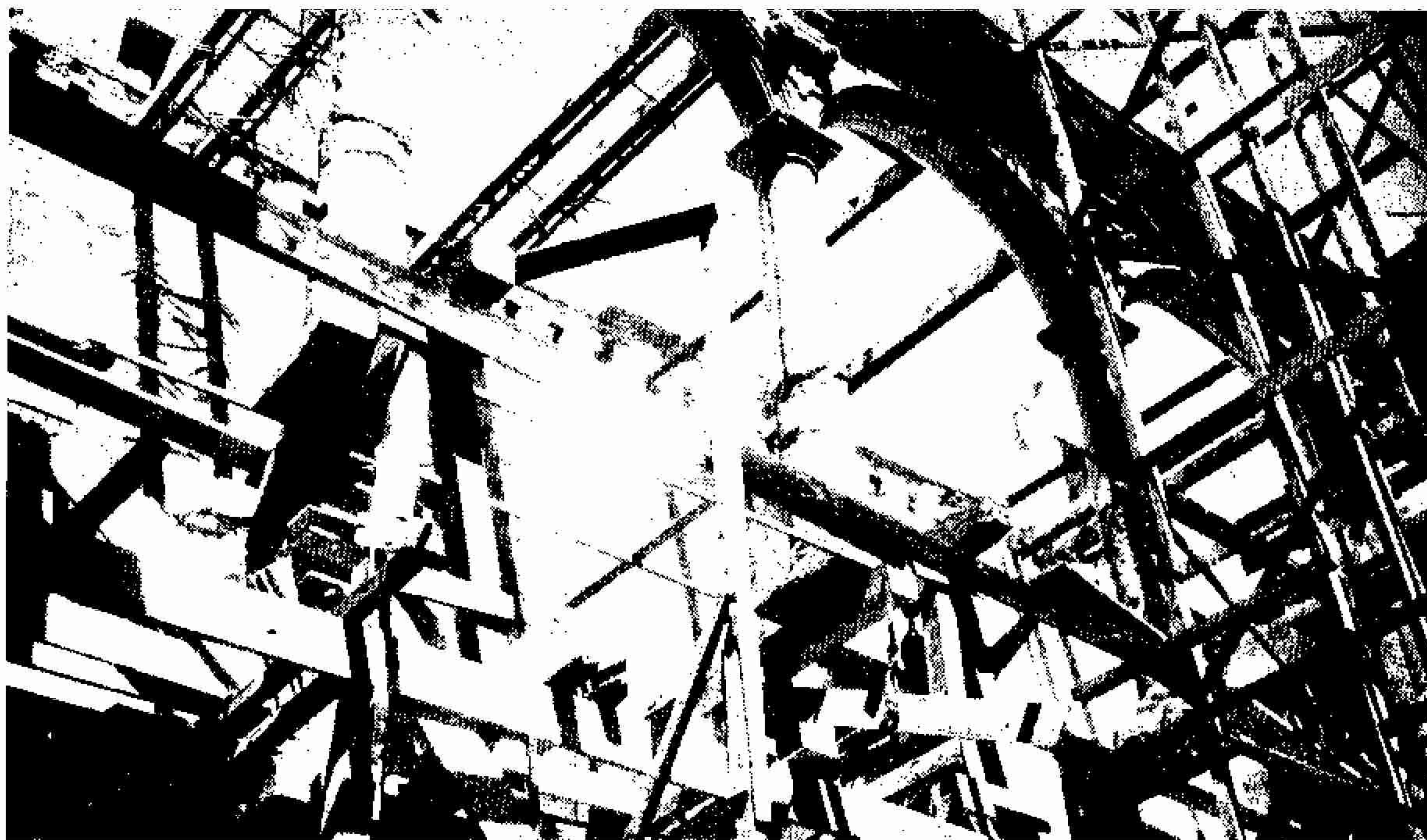
Palacio del Ayuntamiento. Apuntalamiento de la antigua galería.—Govantes y Cabarrocas, arquitectos. Raúl Simeón, contratista.
