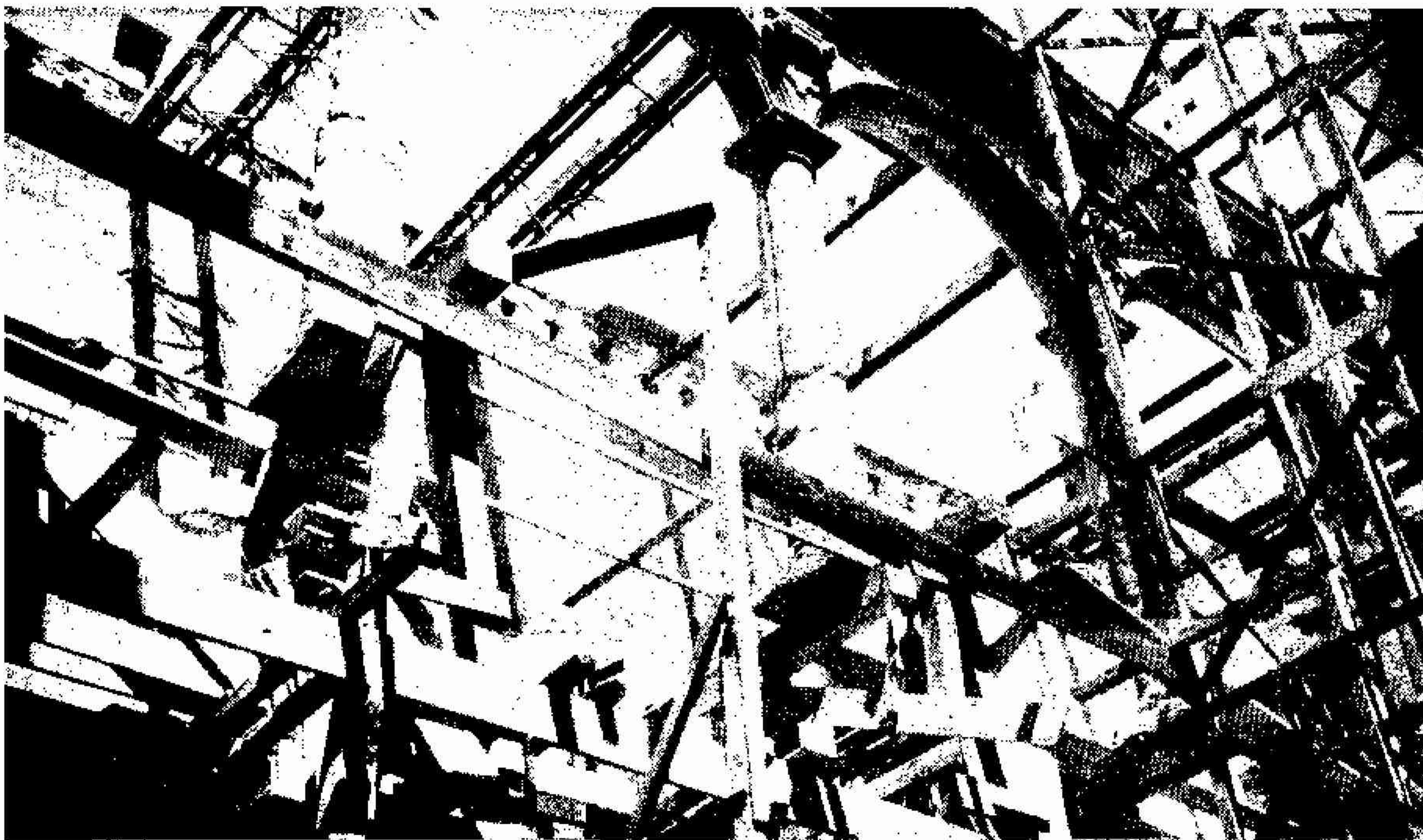
Apuntalamiento de la galería alta
