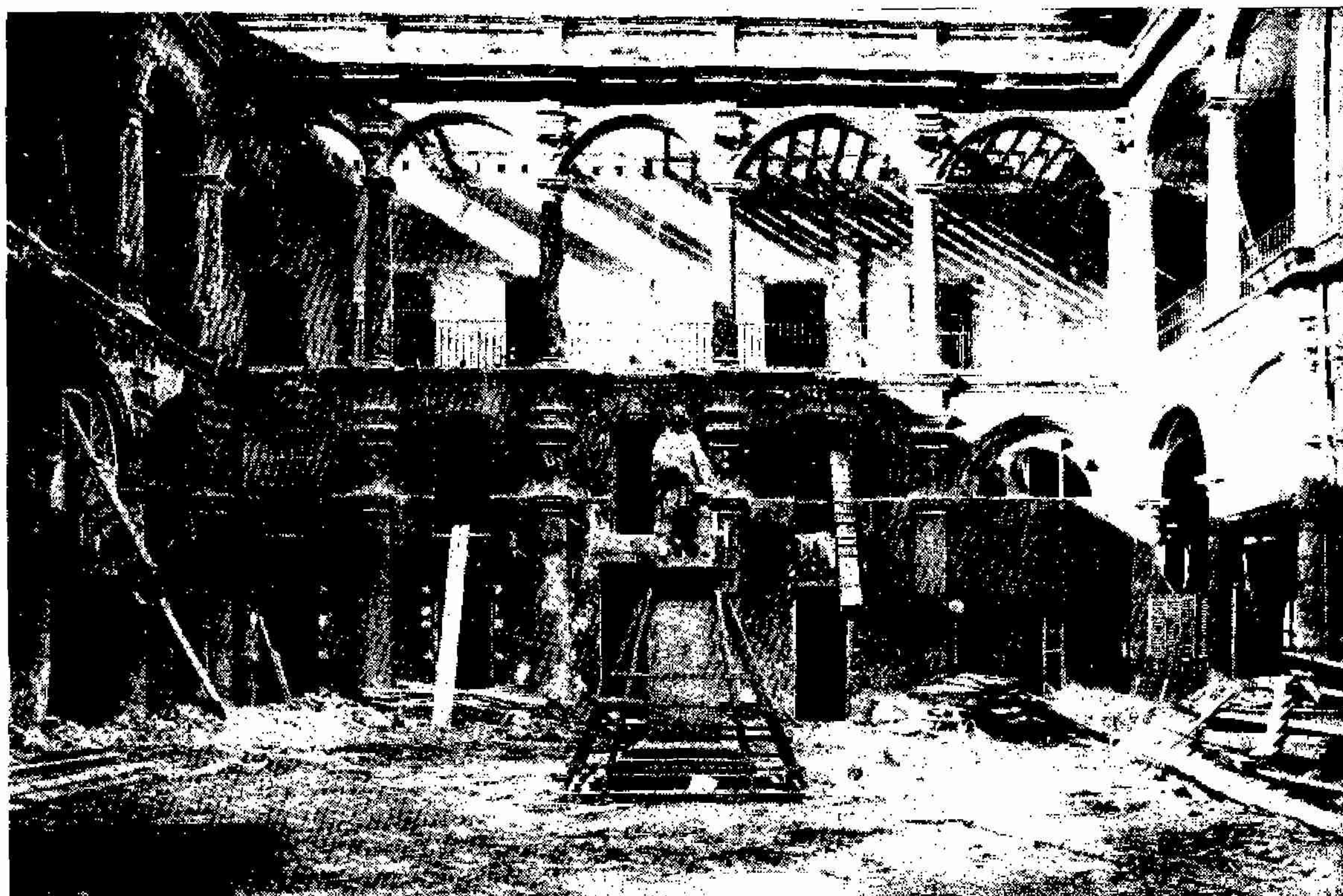
Vista tomada durante la demolición
