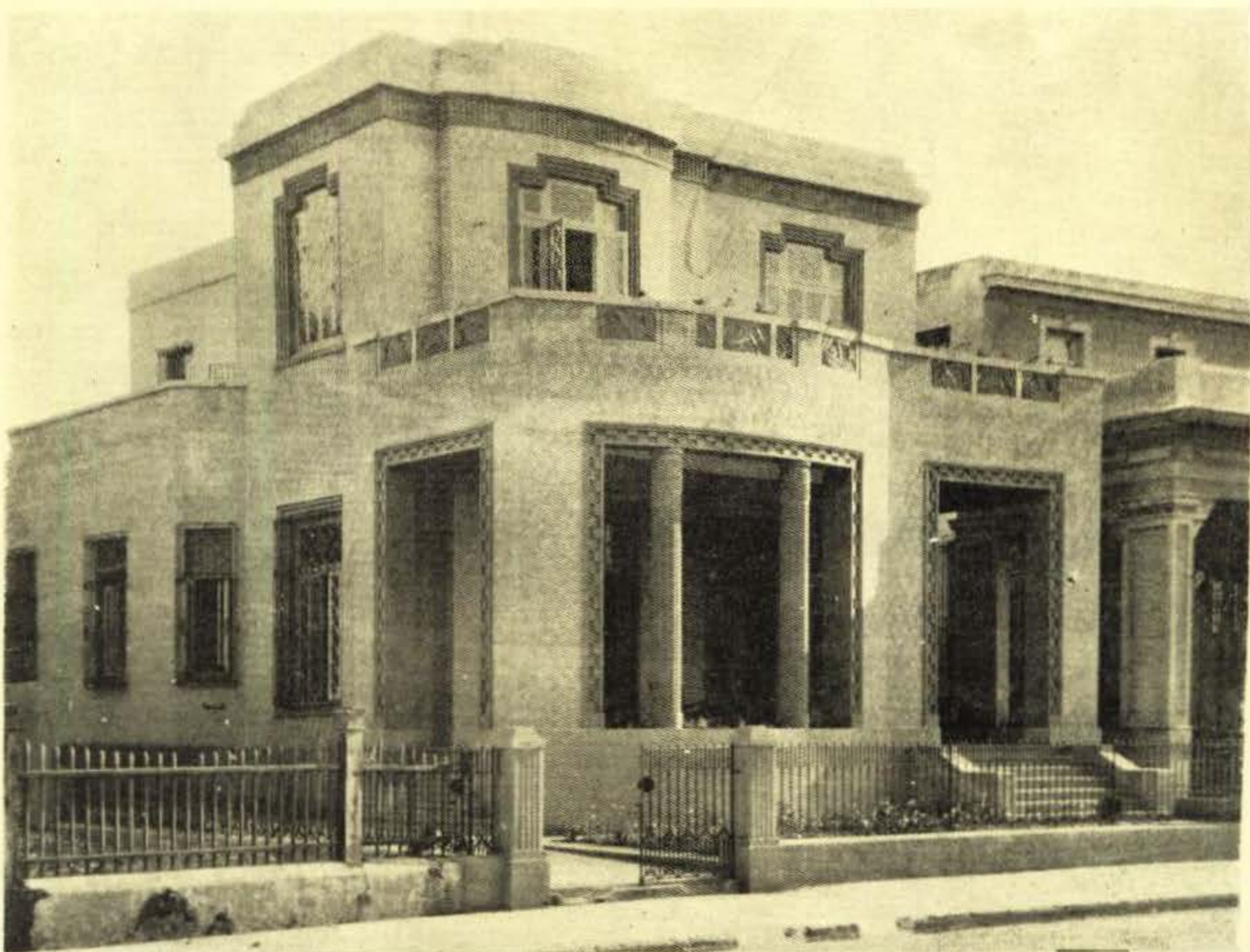
En estas dos fotografías de una residencia proyectada y construida por los Arquitectos: Maruri y Weiss en la calle de Línea y Paseo, Vedado, pueden observar algunos desconfiados propietarios la igualdad existente entre el proyecto y la obra.
