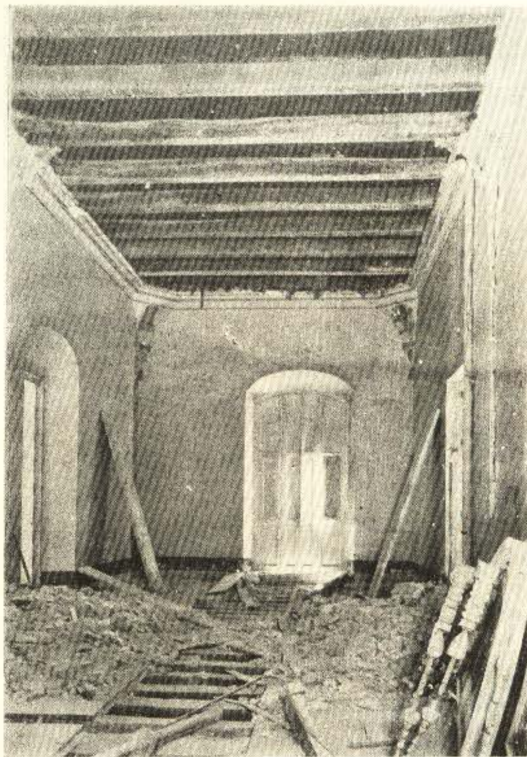
Detalles de la viguetaría del techo del Ayuntamiento
