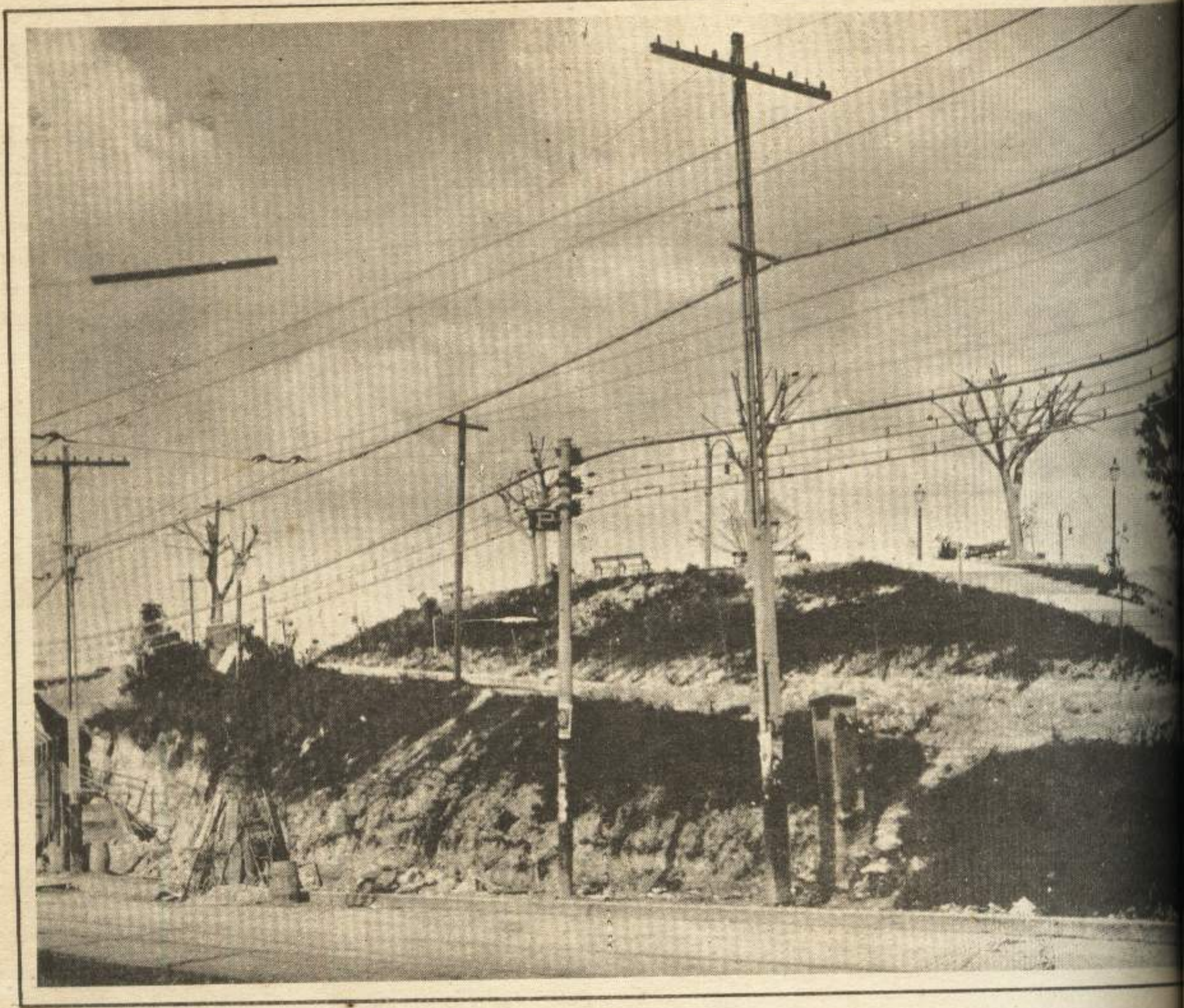
UN ASPECTO DE LA OBRA DE OCULTACION DE LA LOMA DE LA IGLESIA DE JESUS DEL
