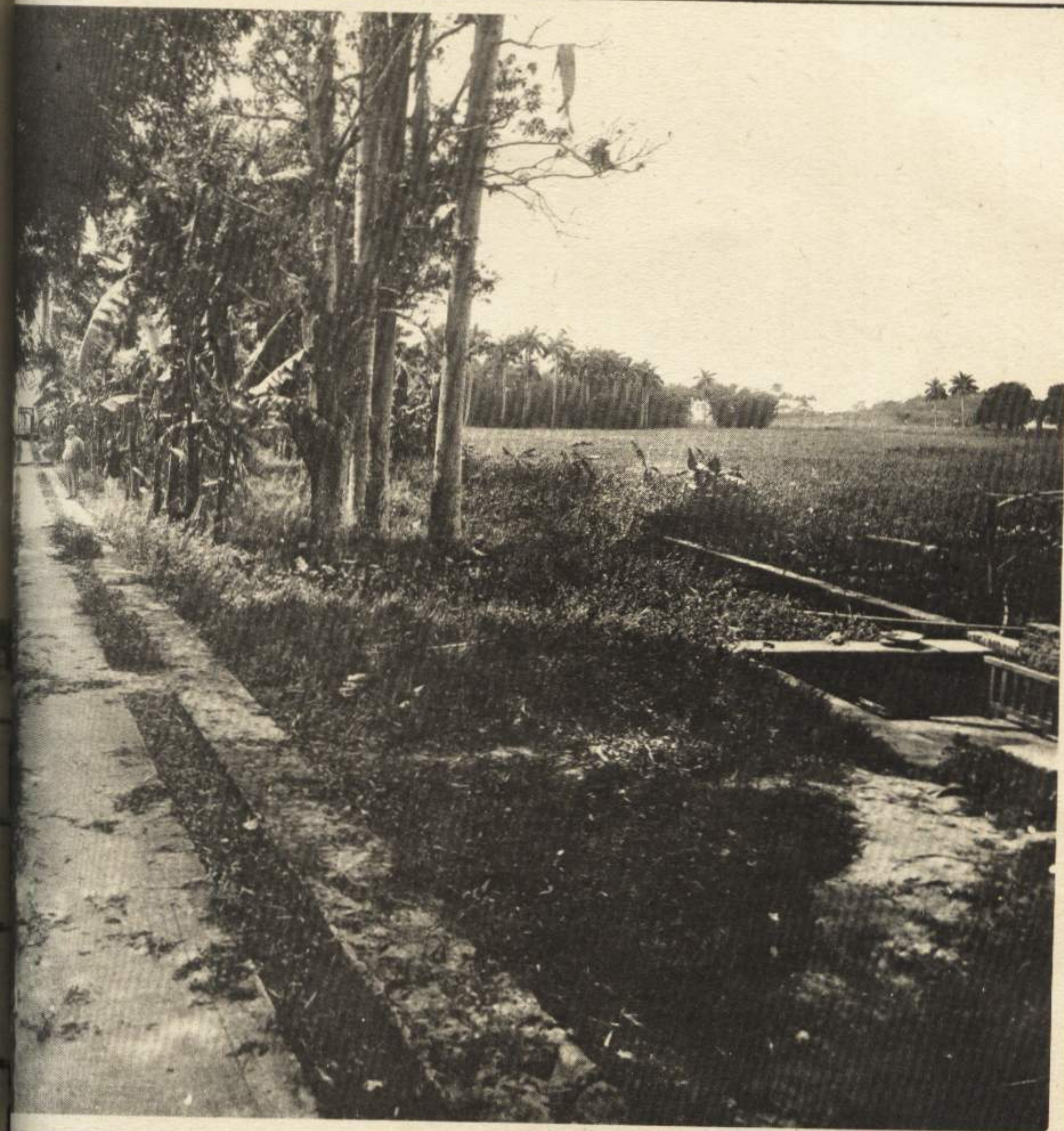
Canal del río a las turbinas
