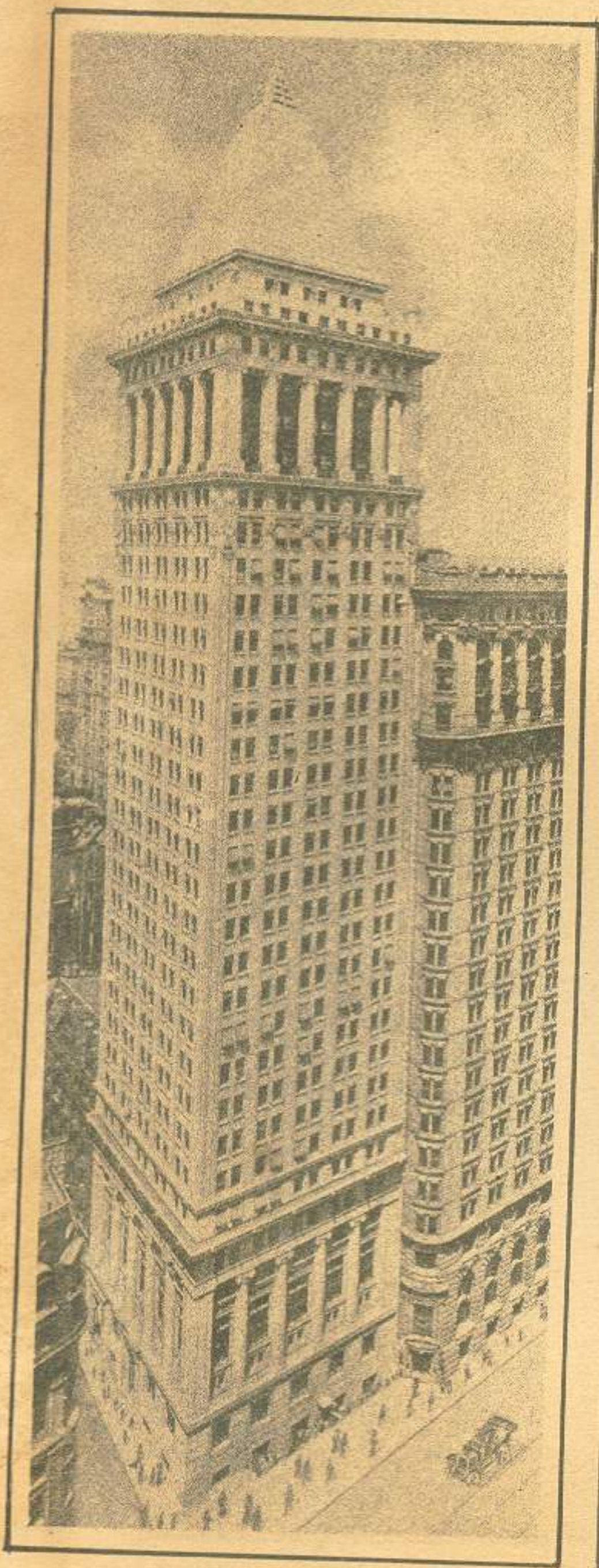
Bankers Trust Co. Construido en 1911. Se alza en Wall y Nassau streets.
