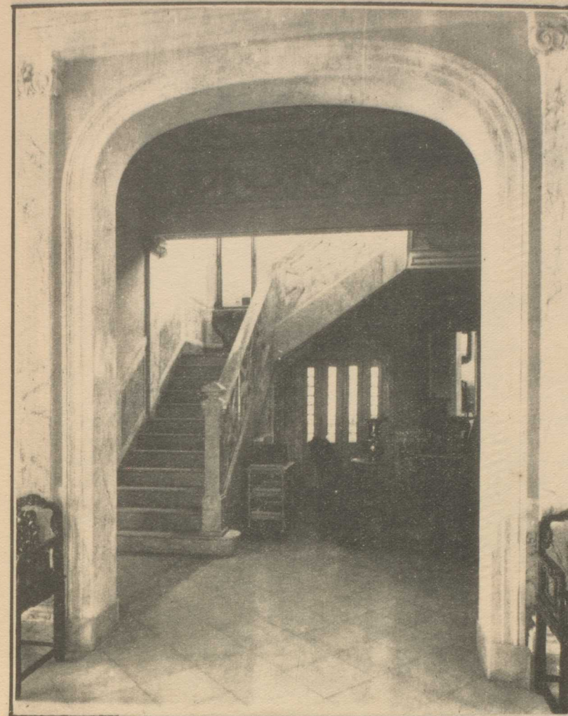
Vestíbulo y escalera
