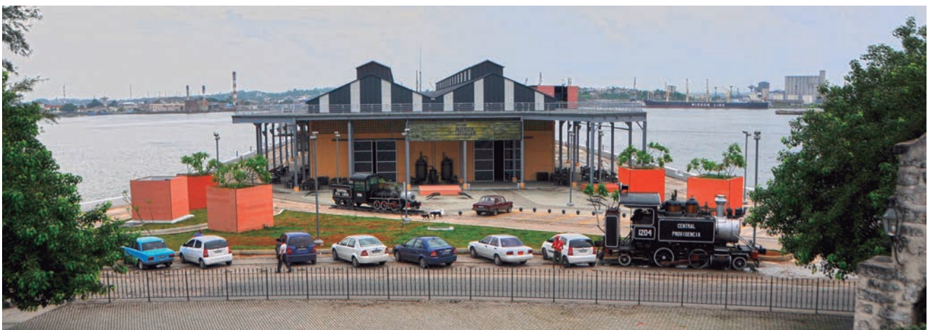
Formando parte de la reanimación de la Avenida del Puerto, que va desde el tramo del Muelle de Caballería hasta el Centro Cultural Almacenes San José, el Almacén de la madera y el tabaco está situado al lado de este último, al final de la Avenida de Paula. Este establecimiento fue reconstruido respetando la misma estructura arquitectónica que tenía cuando fue erigido, entre 1906 y 1908.
