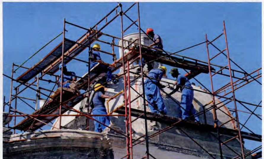
Alumnos de la especialidad de albañilería de la Escuela Taller Gaspar Melchor de Jovellanos enfrascados en terminar una cúpula del panteón de la familia Loredo, que tuvo que ser reproducida luego de derrumbarse completamente por el paso de un ciclón. Ellos integran el grupo de más de 30 estudiantes de diversas especialidades que tienen a su cargo la restauración total del camposanto.
