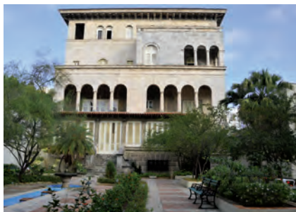
Arriba: fachada principal de la sede del Museo Napoleónico, palacet de estilo neoflorentino que constituye un edificio único en su contexto. Con entrada por la calle San Miguel, a través de un amplio corredor puede accederse a su bello patio interior, ubicado en la parte posterior de la vivienda (abajo).
