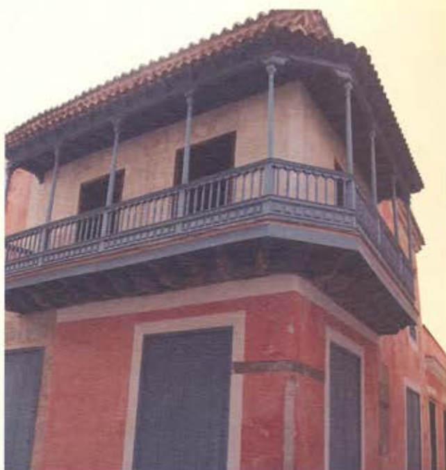
Actualmente en restauración por la Oficina del Historiador de la Ciudad, esta casa –sita en la calle Teniente Rey 59– representa el estilo prebarroco de finales del siglo XVII, tal y como lo definió el arquitecto Francisco Prat Puig, cuyo nombre identificará este inmueble, previsto como sede de una institución cultural que estimulará los estudios de la arquitectura colonial cubana.
