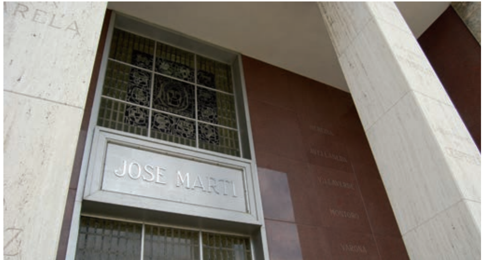
La construcción de este edificio fue posible gracias a la Ley No. 20, del 21 de marzo de 1941, que gravó a la producción azucarera con un impuesto de ½ centavos sobre cada saco de azúcar de 325 libras y la institucionalización de la Junta de Patronos, la cual tuvo al Dr. Emilio Roig de Leuchsenring como primer secretario, y a Don Fernando Ortiz como representante de la Sociedad Económica de Amigos del País.
