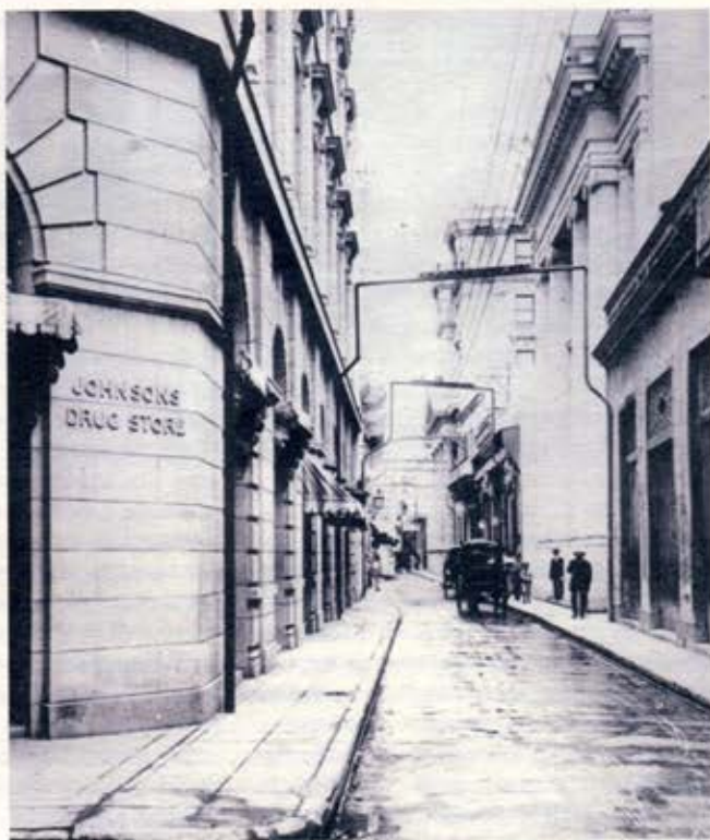
Desde 1914 la Droguería Johnson ocupa el edificio con esquina en Obispo y Aguiar. En 2000 fue restaurada íntegramente para convertirla en farmacia de la comunidad.
