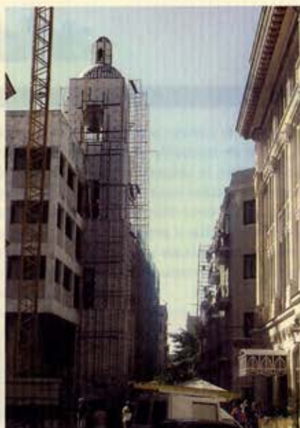
Estado actual del proyecto de restitución de la torre-campanario que, con 31 metros de alto, rememora la forma original de la que se erigió en la otrora iglesia de San Juan de Letrán.
