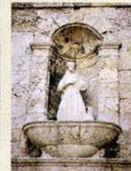
Sobre la superficie de la fachada se agrupan (o aíslan) las reiteradas columnas adosadas a pilastras que enmarcan los vanos y nichos con esculturas: de San Francisco de Asís y de Santo Domingo, ya muy erosionadas. Una moldura de trazado barroco realza, en el centro de la fachada, un relieve de la Inmaculada Concepción.
