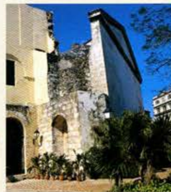
CÚPULA DESAPARECIDA Un hermoso jardín dedicado a la Madre Teresa de Calcuta cubre toda la parte trasera del otrora conjunto religioso, donde antes (línea discontinua en rojo) se levantaban la cúpula de la iglesia y otros patios secundarios del convento.
