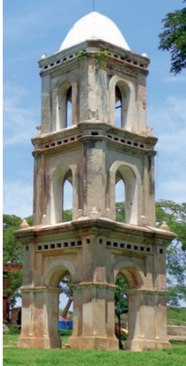
San Isidro de los Destiladeros se rescata progresivamente por la Oficina del Conservador de Trinidad.
