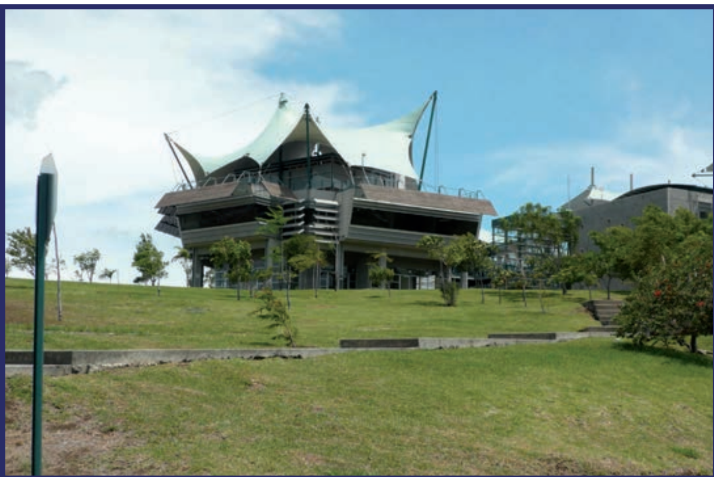
BRUNO STAGNO Oficinas de la empresa Holcim / Fotografía: Beto Guillén / Tomada de http://www.panoramio.com
