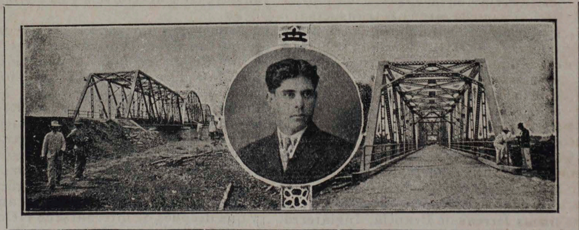
PUENTE SOBRE EL RIO "ZAZÁ".—EL INGENIERO DIRECTOR SEÑOR EVELIO GOVANTES FUENTES
