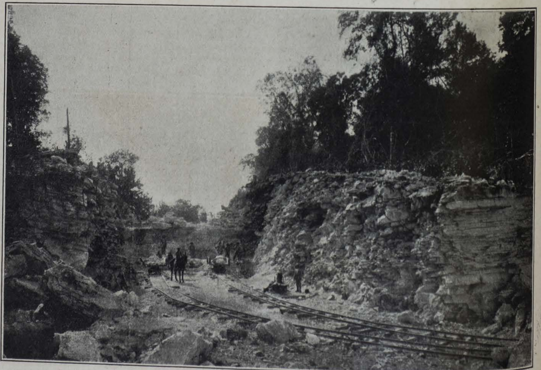
Trabajos para la línea del "Havana Central"
