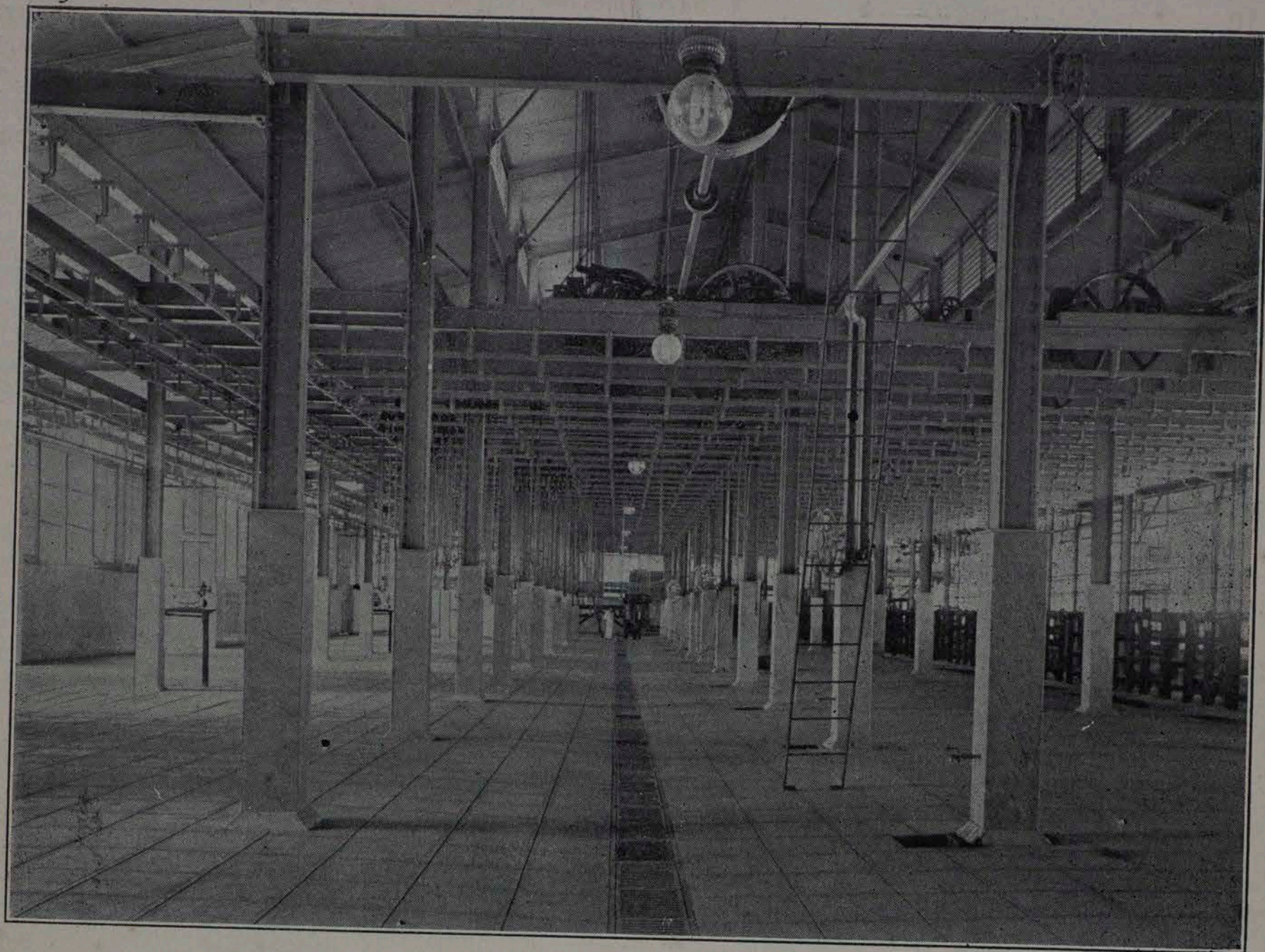
Matadero Industrial.—Nave Central de matanza
