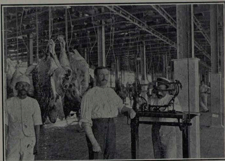
Matadero Industrial.—una de las romanas Fairbanks
