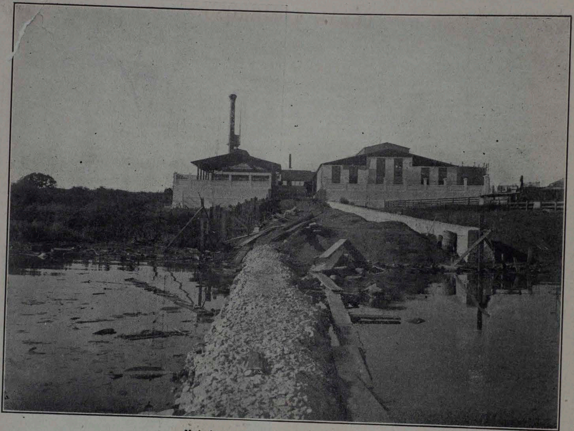
Matadero Industrial.—Muelle en construcción
