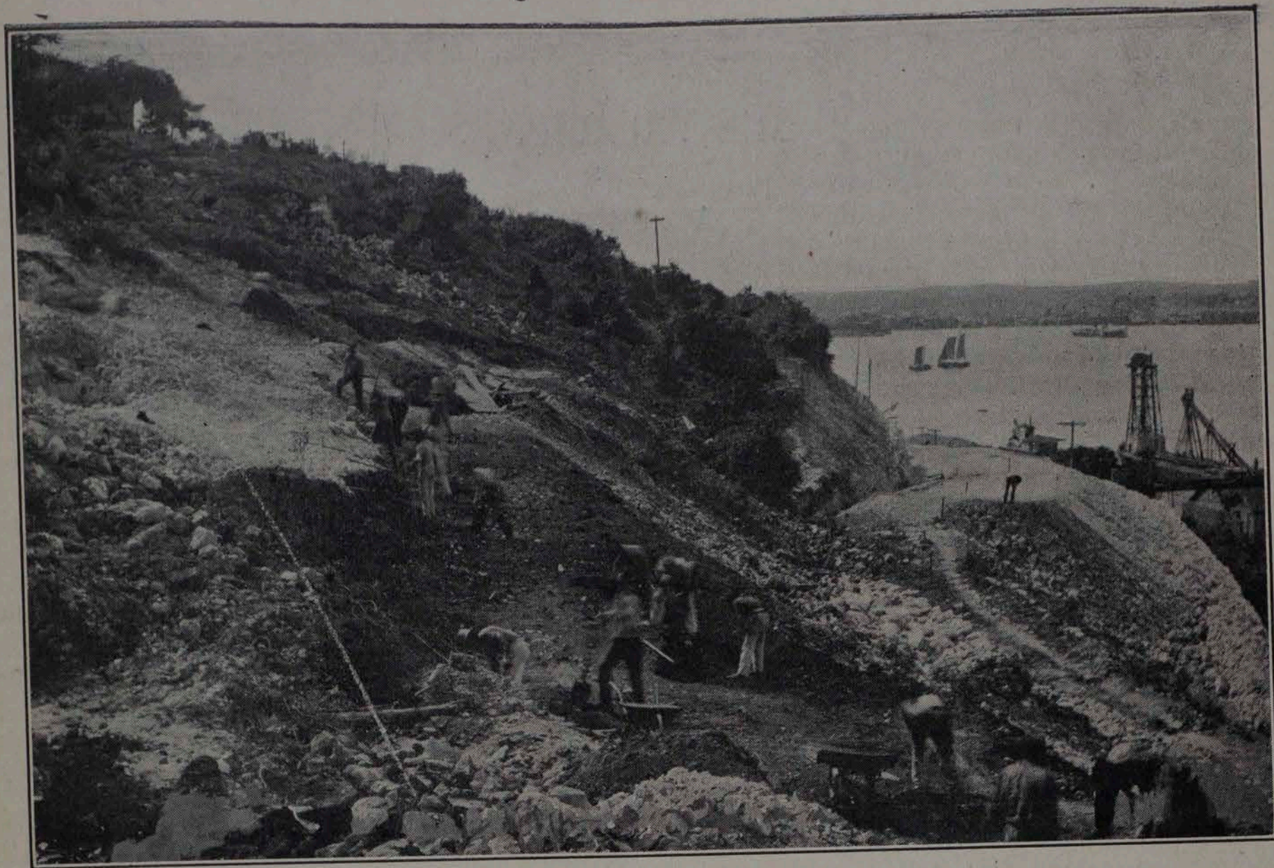
HABANA ILUSTRADA.—Construcción de la Carretera que sale de Casa Blanca á la Cabaña
