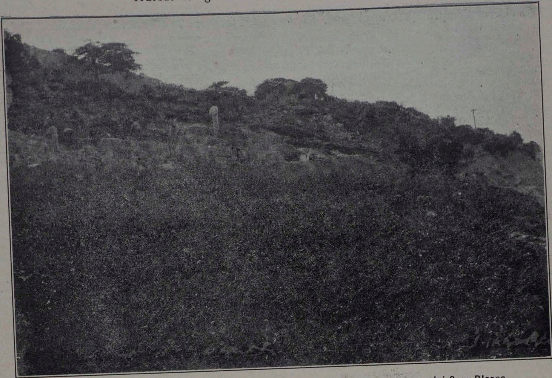
HABANA ILUSTRADA.—Derrumbe de minas en la Cabaña para la Calzada que vá á Casa Blanca
