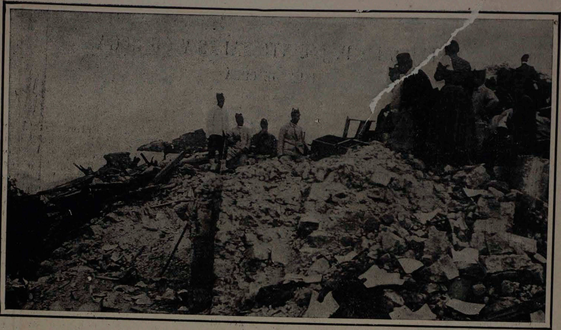
Soldados que buscan entre las ruinas de una casa los cuerpos de sus ocupantes
