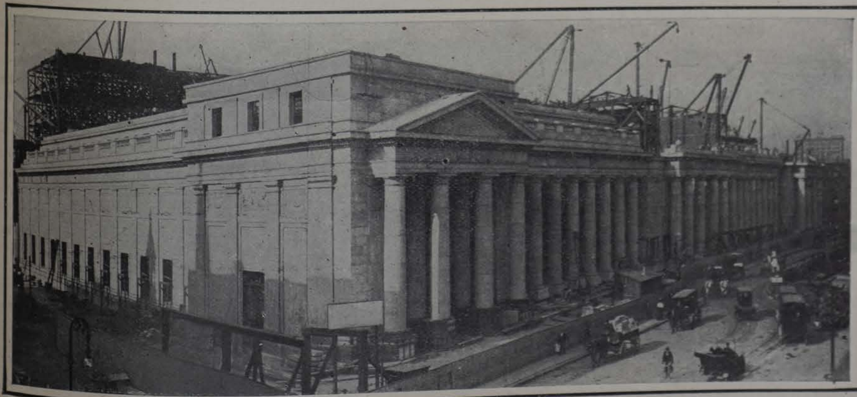
Gran edificio en construcción, en el centro de Nueva York, destinado á estación terminal del Ferrocarril de Pennsylvania. Una vez terminado será la estación más grande del mundo
