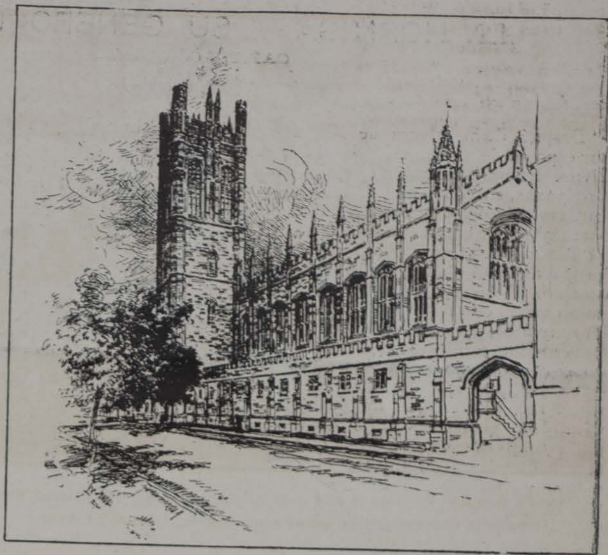
Edificio y torre de Hutchinson, de la gran Universidad de Chicago
