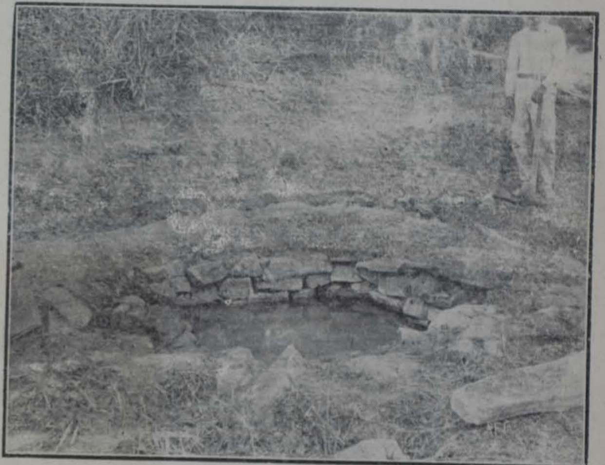
Pozo "El Acueducto", Cabañas
