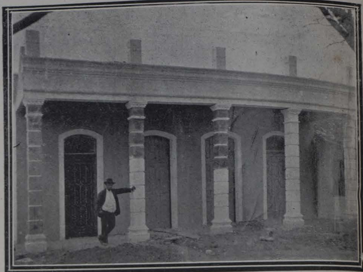
UNO DE LOS NUEVOS EDIFICIOS CONSTRUIDOS POR EL SR. SUASTON
