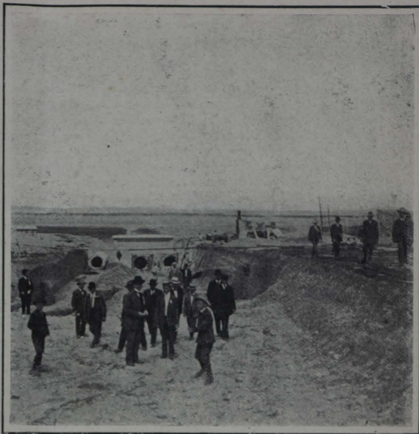
MONTANA.—Planta para elevar el agua del canal
