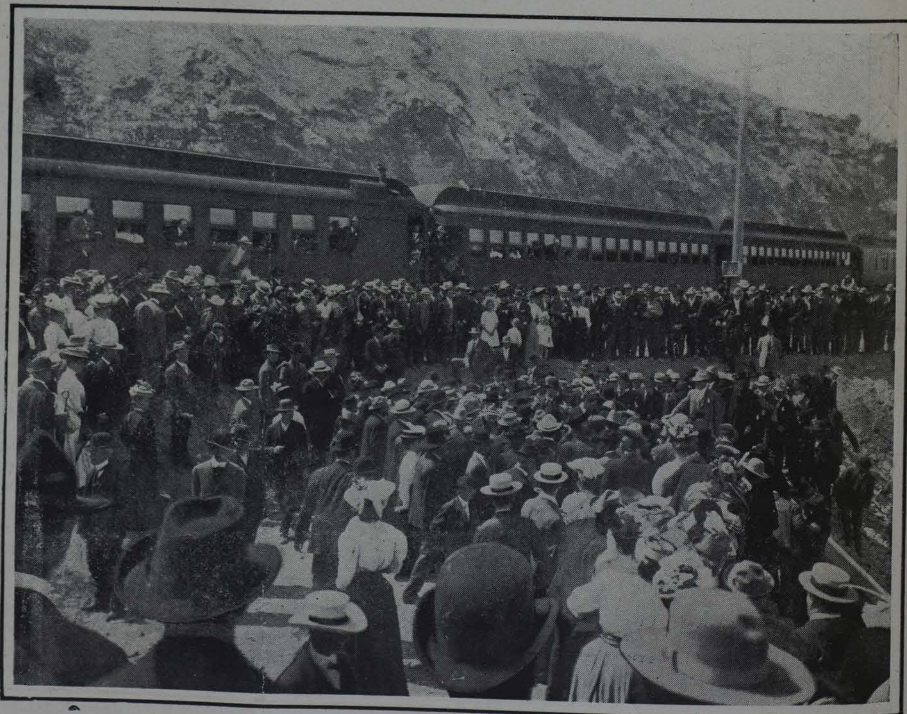
MONTANA.—La muchedumbre aguardando con interés el momento en que se abran las compuertas del canal de riego
