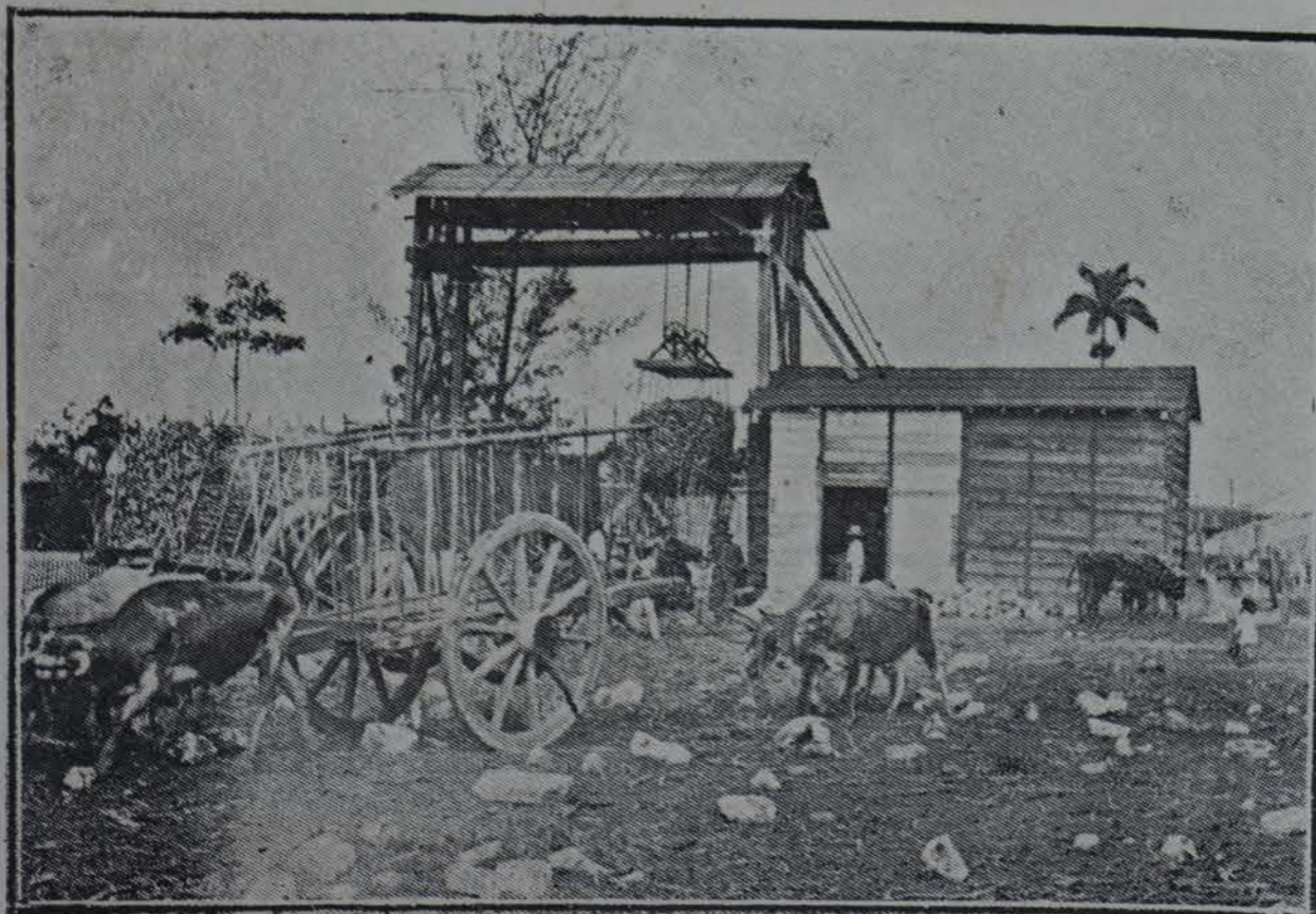
MADRUGA.—Trasbordadora y pesa del ingenio San Antonio, junto á la estación del ferrocarril
