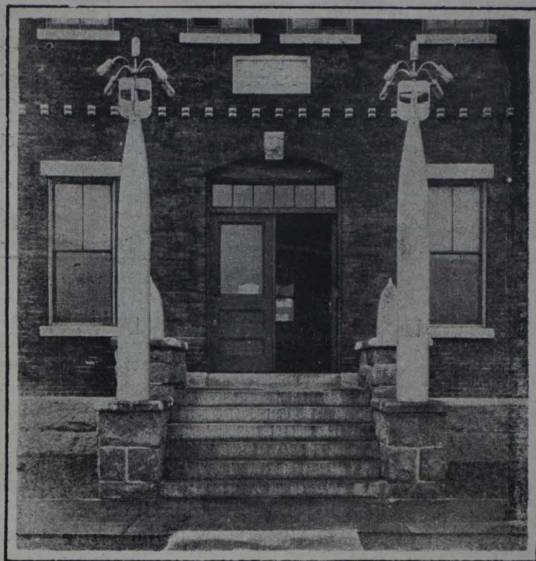
Torpedos españoles usados como postes de luz eléctrica á la entrada del edificio de la Administración
