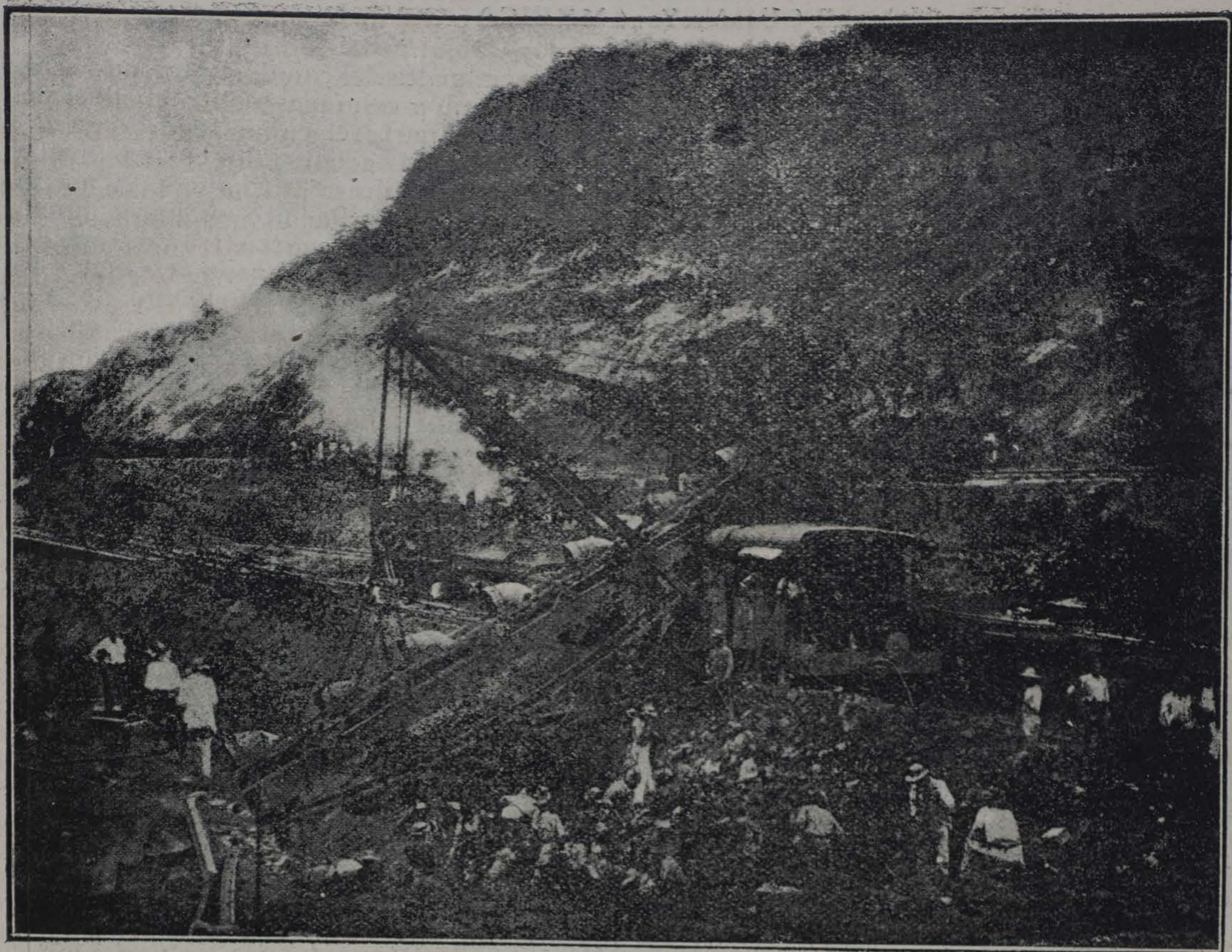
Trabajando en la construcción del canal
