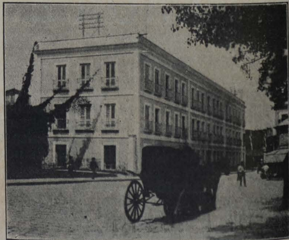
EDIFICIO DE CORREOS, HABANA
