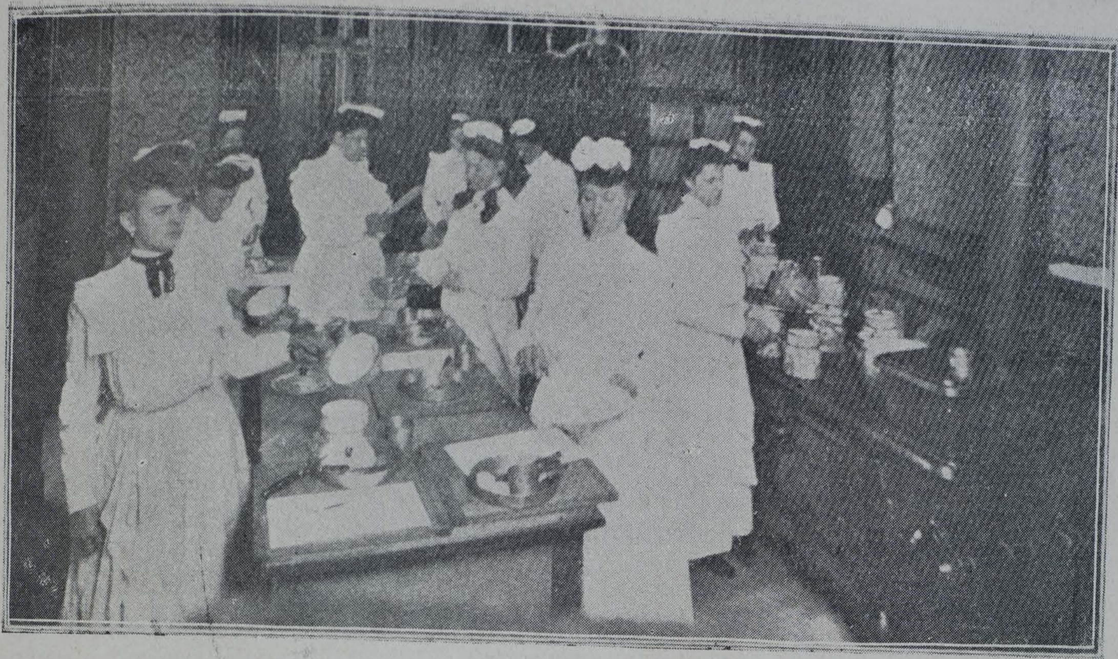
CLASE DE COCINA EN LA ESCUELA DE TRABAJOS MANUALES DE SAINT LOUIS
