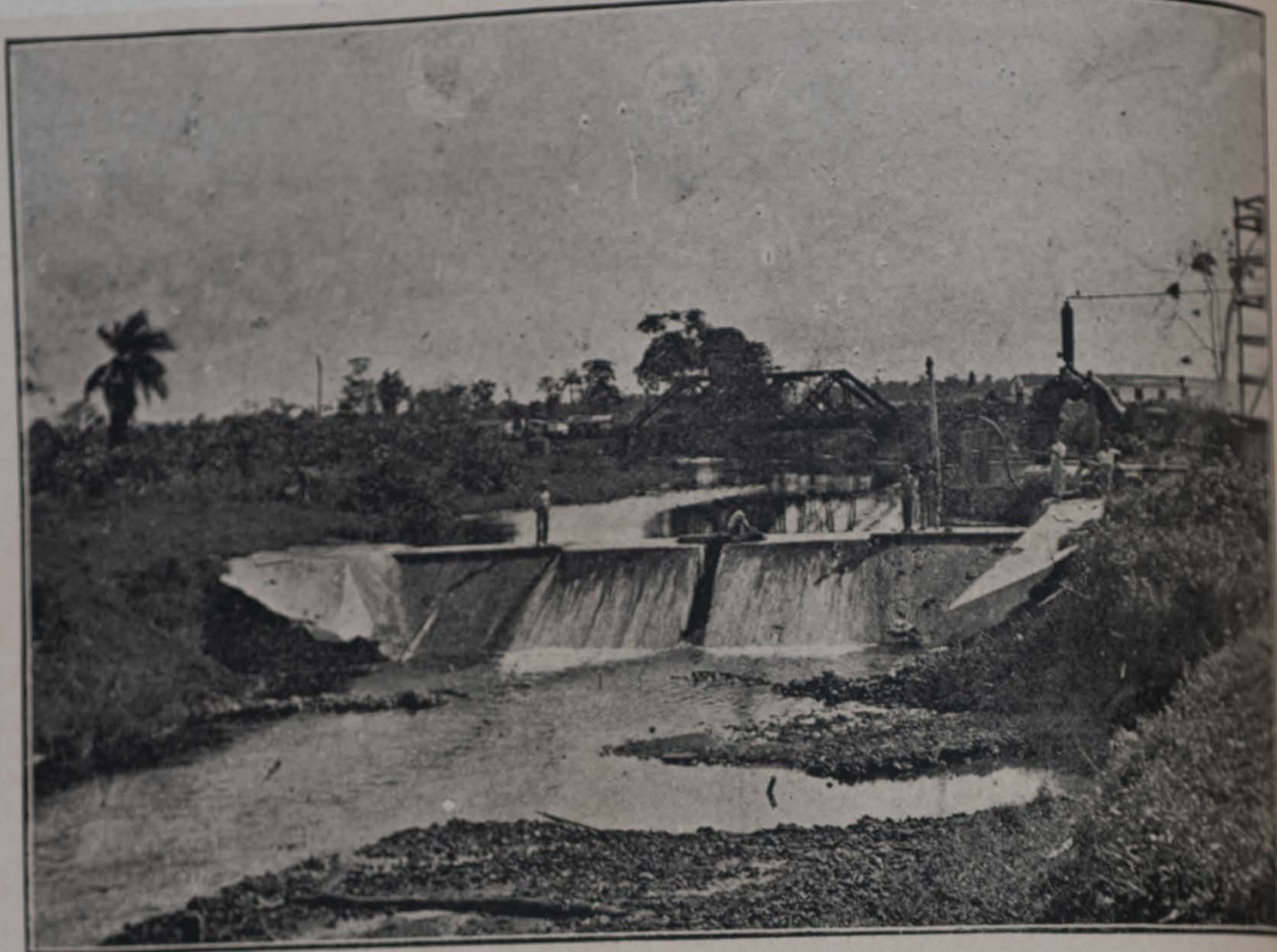
CENTRAL CHAPARRA.—REPRESA Y PUENTE EN EL RÍO CHAPARRA
