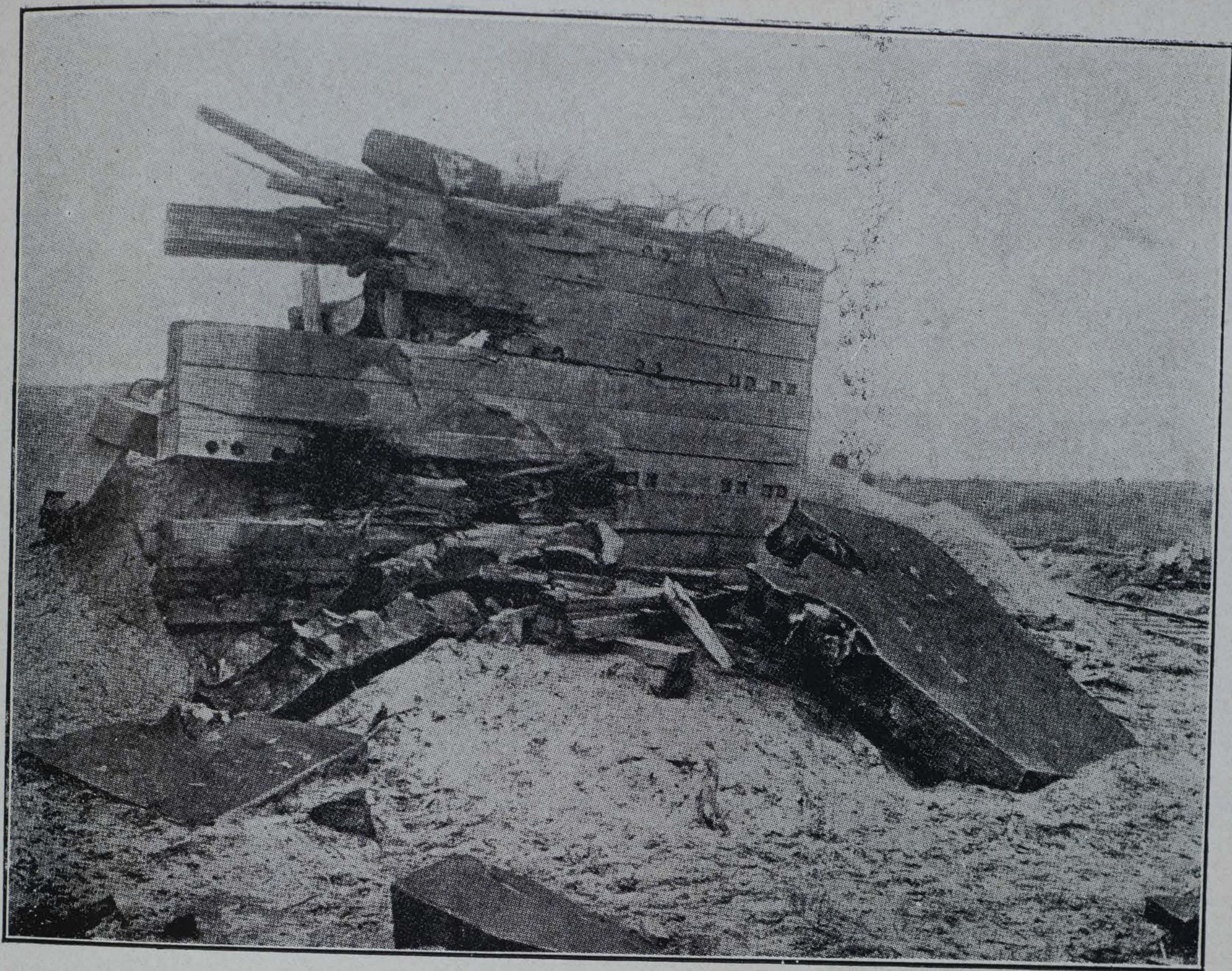
PLANCHA DE DOCE PULGADAS DESTROZADA POR LA MAXIMITA
