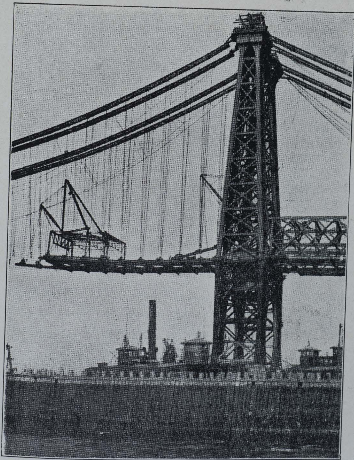
VISTA DE UNO DE LOS PILARES DEL PUENTE DE WILLIAMSBURG Y PARTE DEL TABLERO Ó PISO EN EJECUCIÓN
