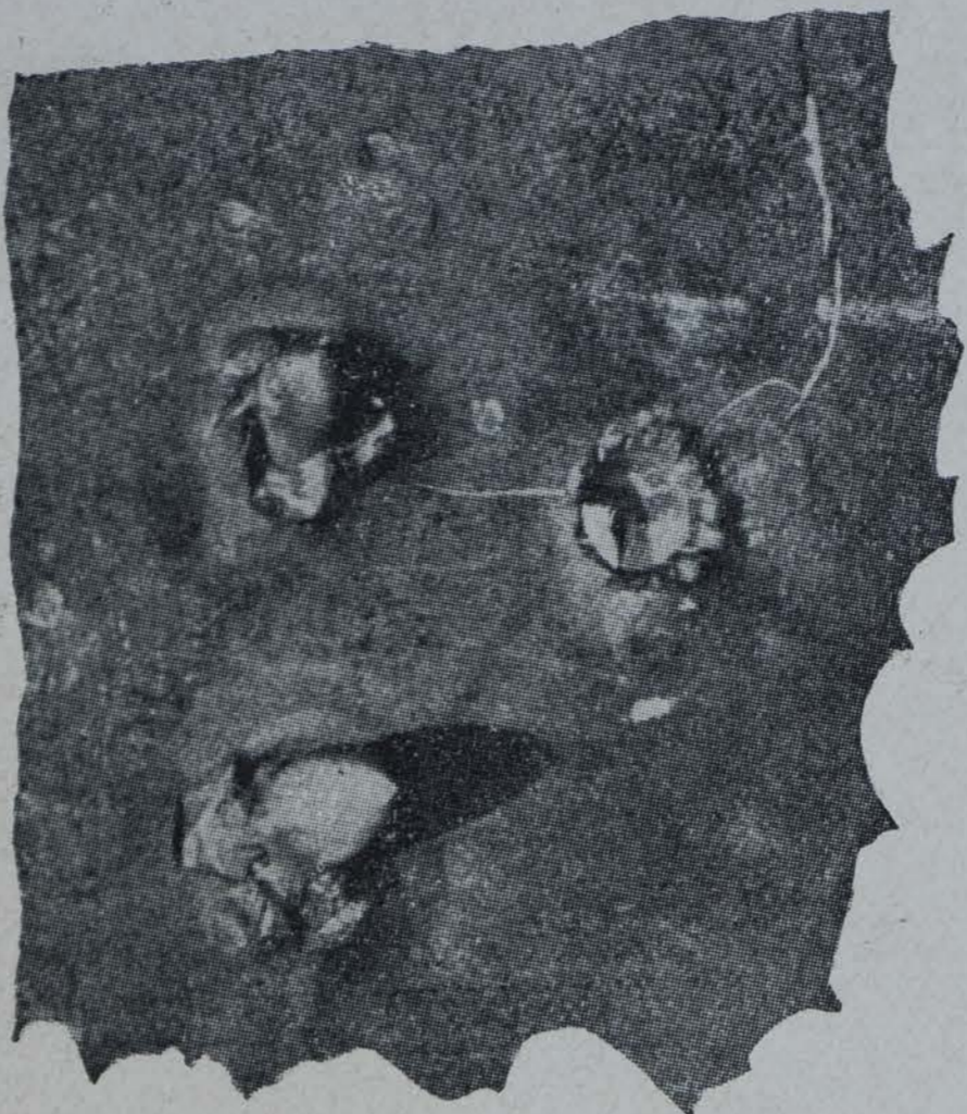
PROYECTILES DE SEIS PULGADAS QUE NO HICIERON EXPLOSIÓN, INCRUSTADOS EN UNA PLANCHA DE TRES PULGADAS
