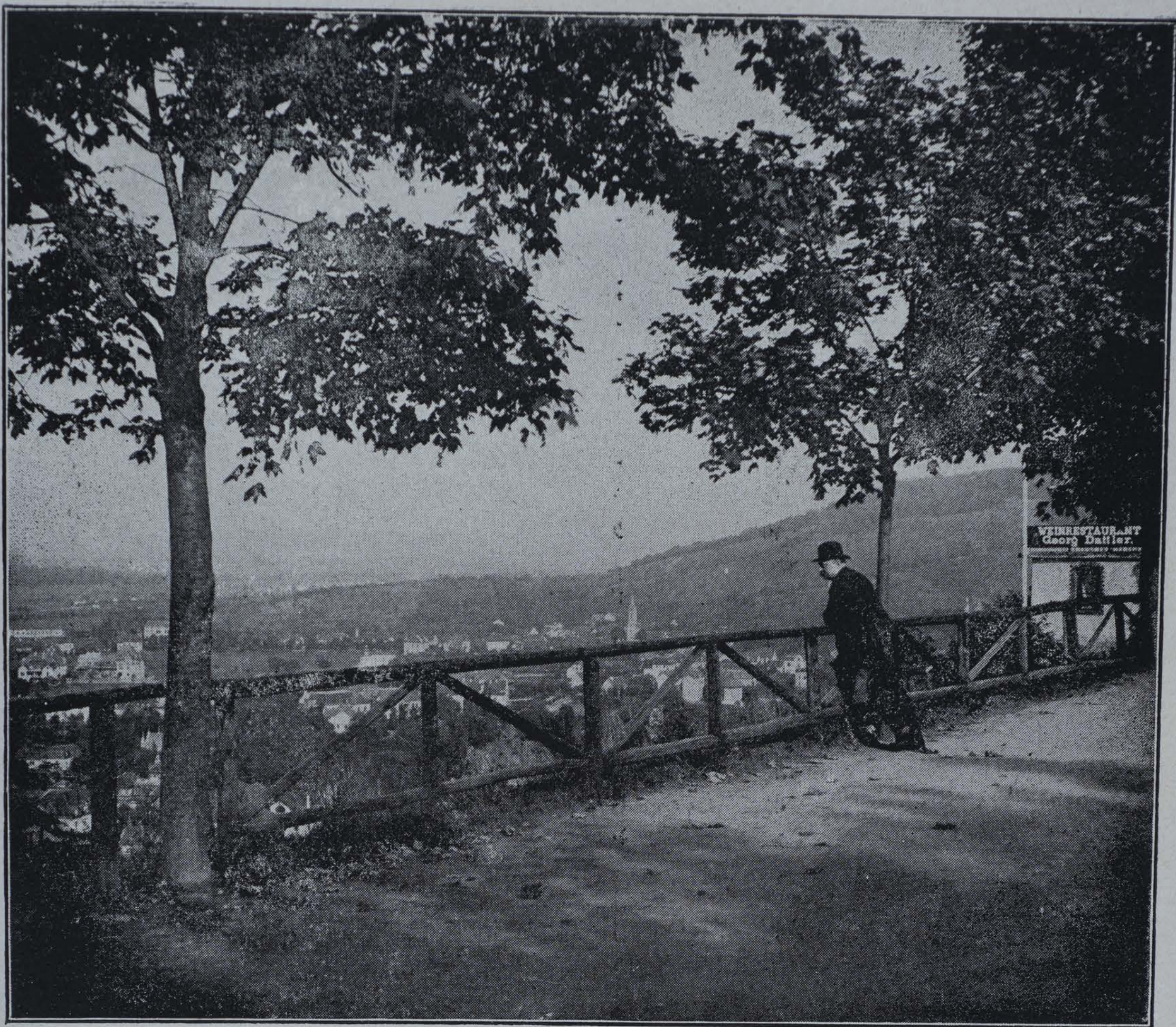
FRIBURGO, ALEMANIA. VISTA DE LA CIUDAD DESDE LA LOMA S CELOSSBERG
