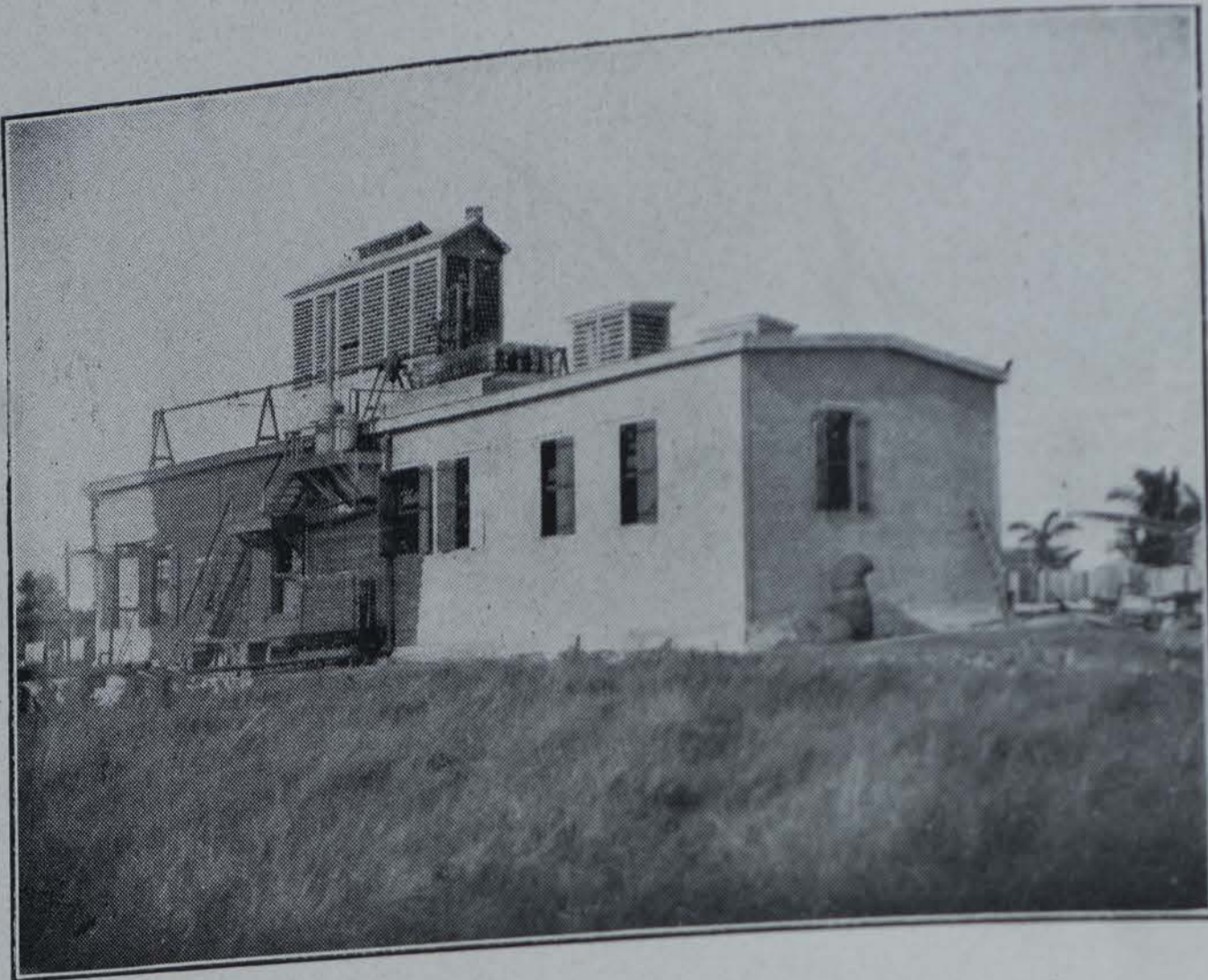
FÁBRICA DE HIELO, FACHADA N., BATABANÓ
