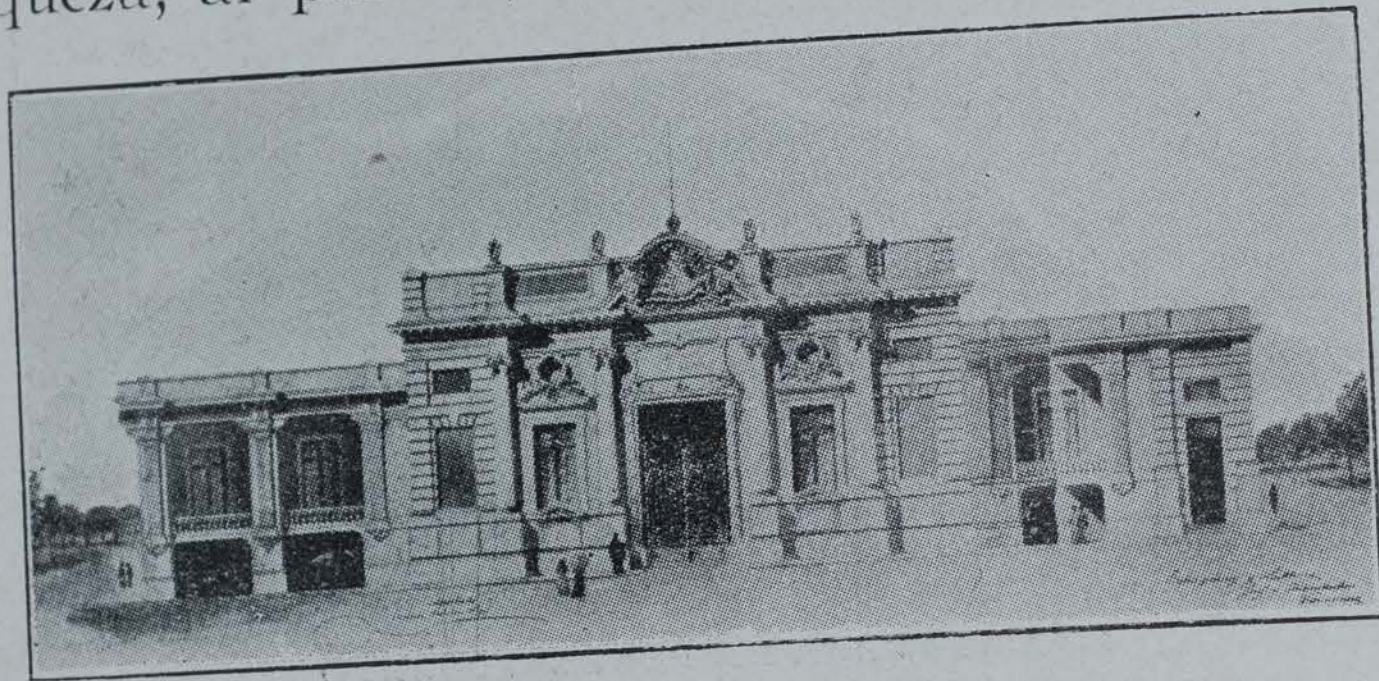
EDIFICIO DE LA NUEVA ADUANA EN VERACRUZ
