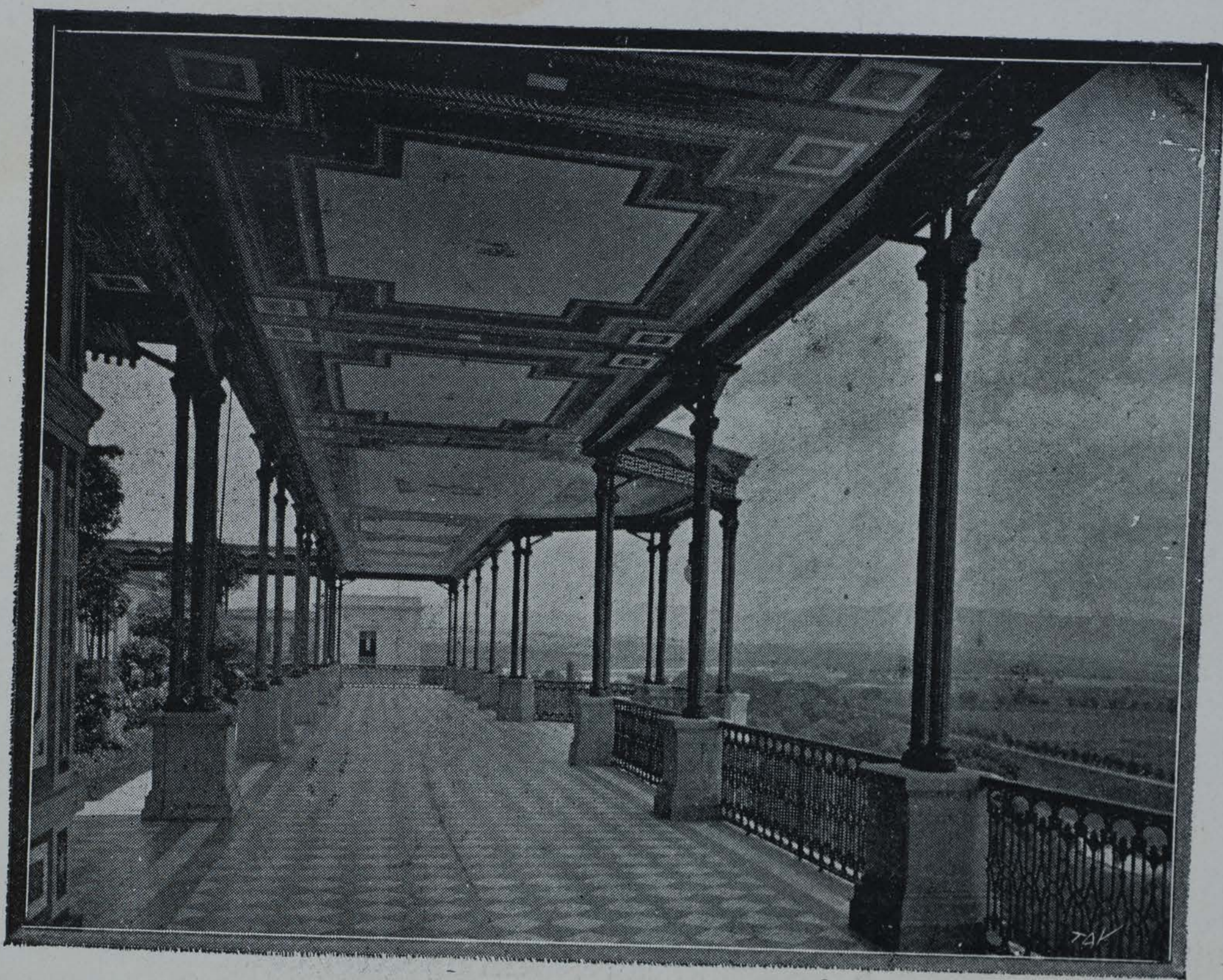
CORREDOR DEL CASTILLO DE CHAPULTEPEC, QUE MIRA AL NORTE. MÉXICO
