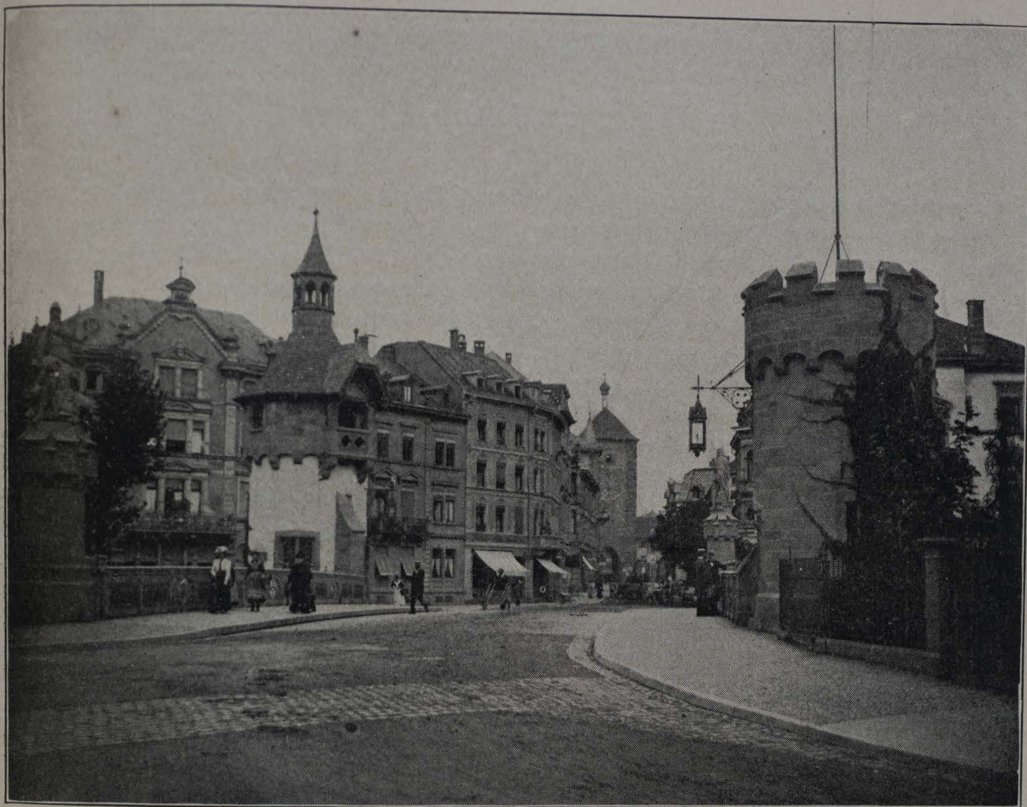
FRIBURGO, ALEMANIA, PUENTE NUEVO, VISTA NORTE
