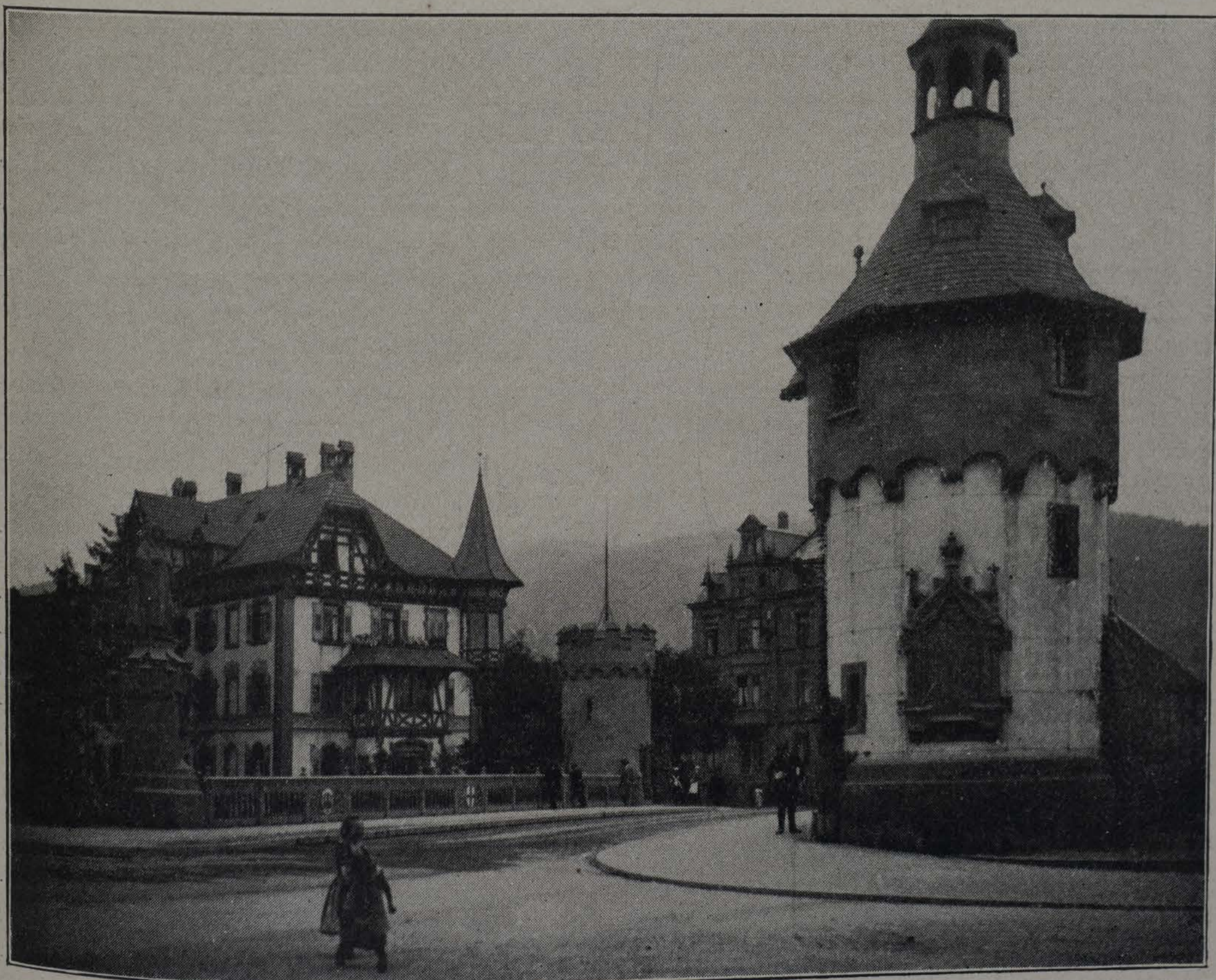
FRIBURGO, ALEMANIA, PUENTE NUEVO. VISTA SUR Fots. de J. B. Gastón
