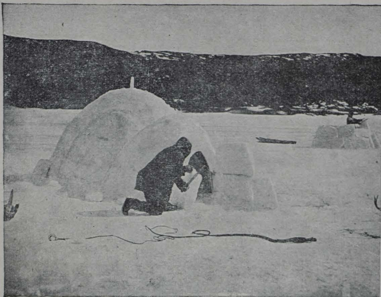
ESQUIMAL CONSTRUYENDO SU CASA
