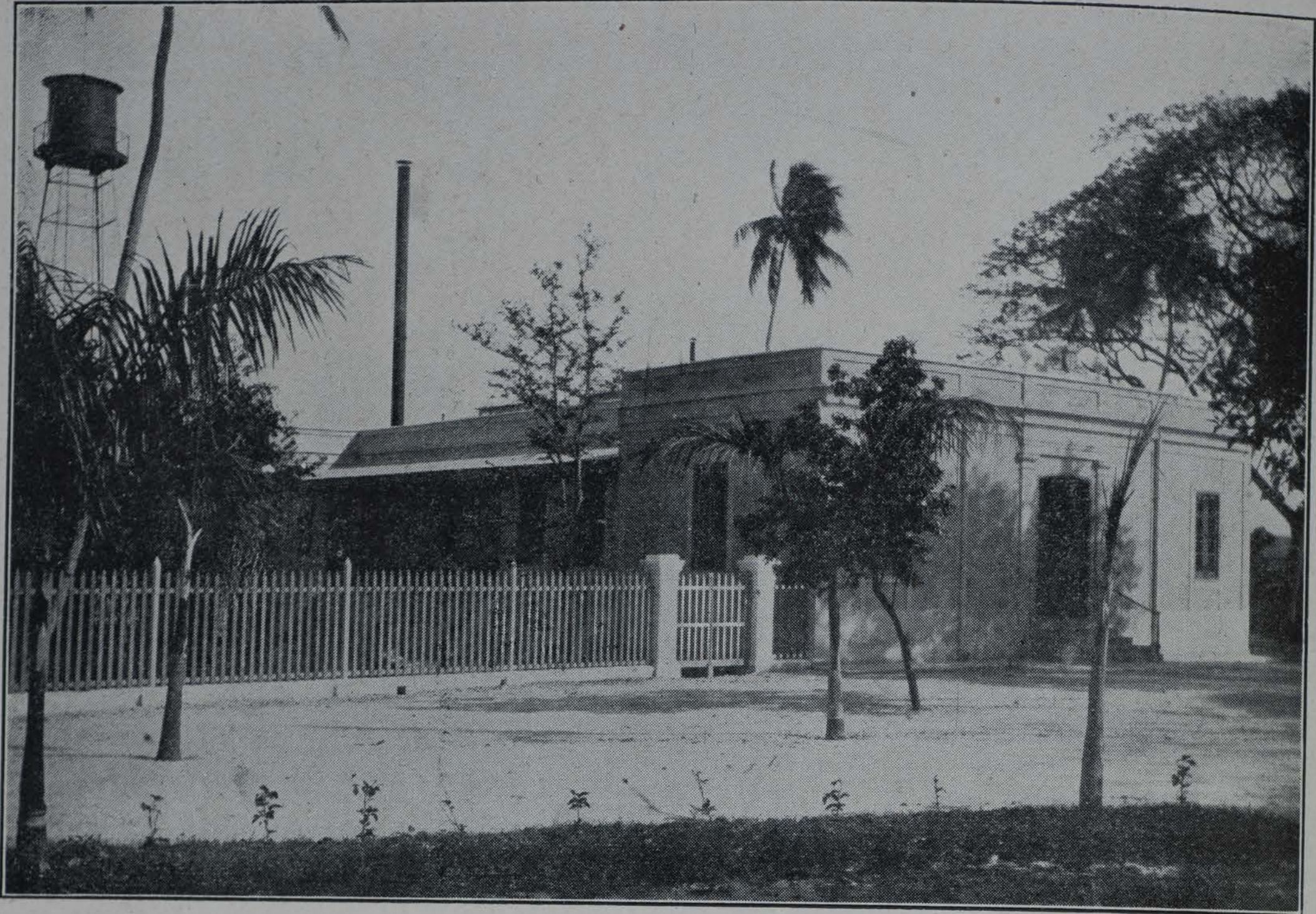
VISTA EXTERIOR DEL NUEVO DEPARTAMENTO DE LAVADO AL VAPOR
