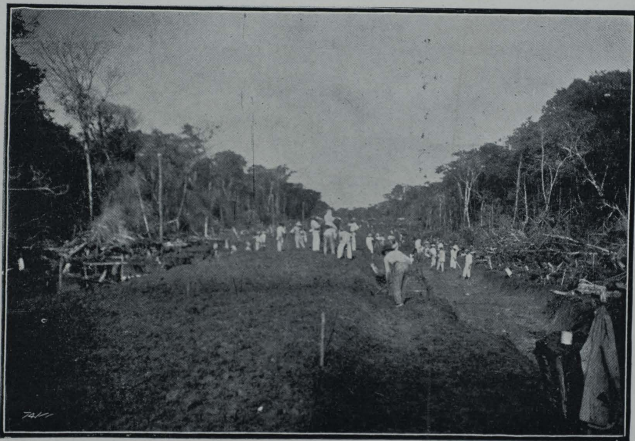
TRABAJADORES ABRIENDO LA VÍA
