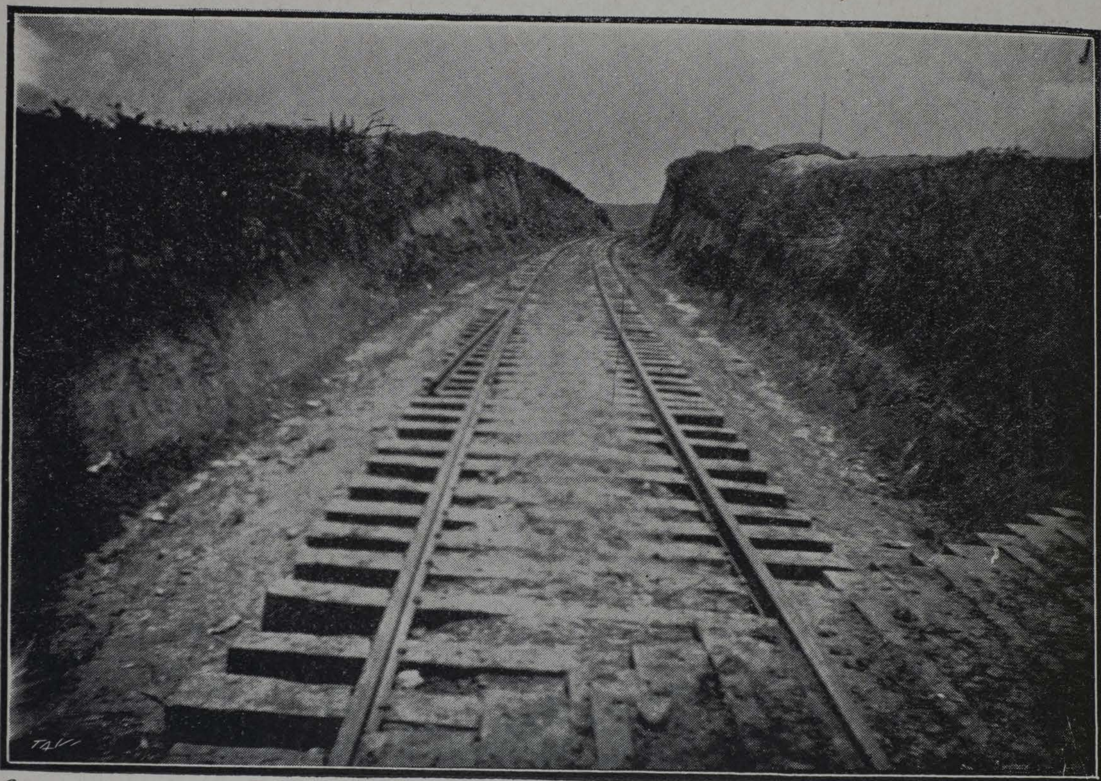
UNA SECCIÓN DE LA VÍA. PUERTO PRÍNCIPE
