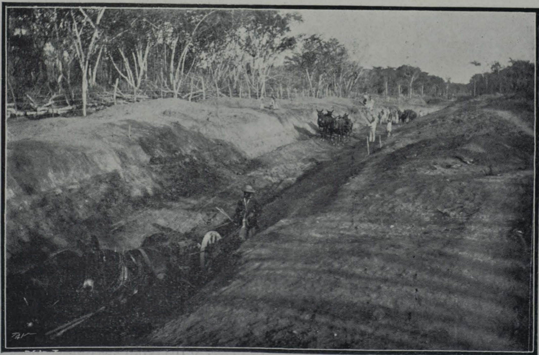
ROTURANDO Y APLANANDO EL TERRENO
