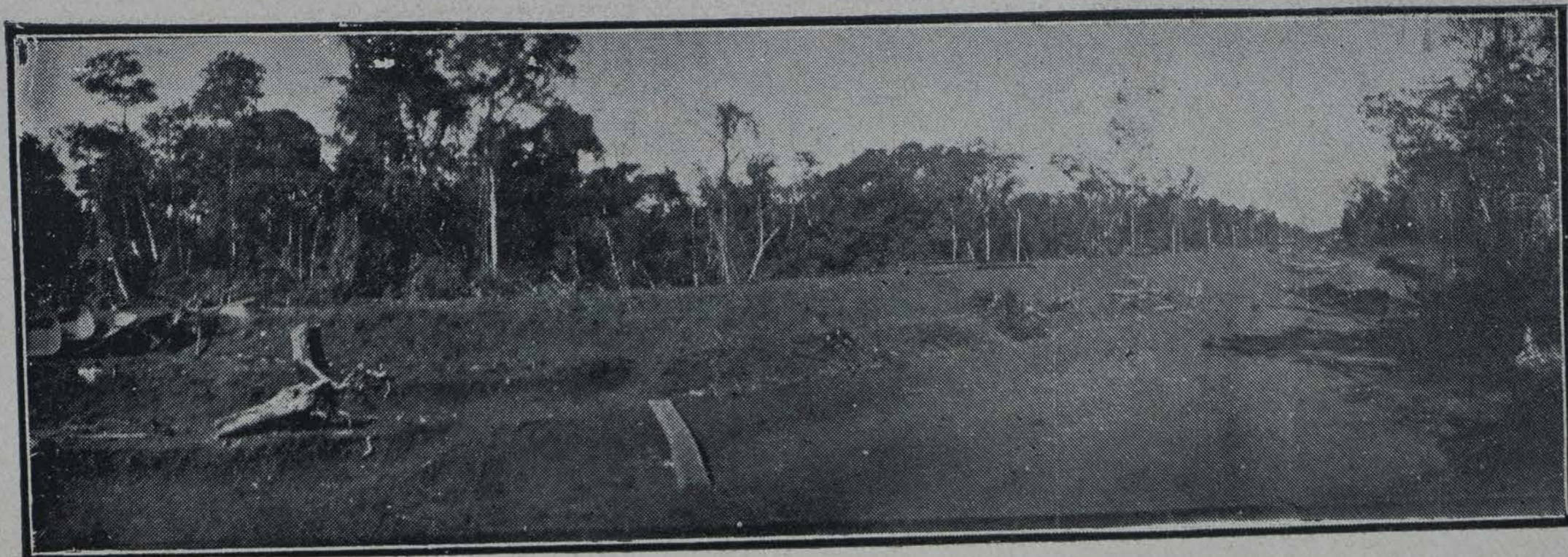
DESMONTE Ó TALA PARA ABRIR LA VÍA
