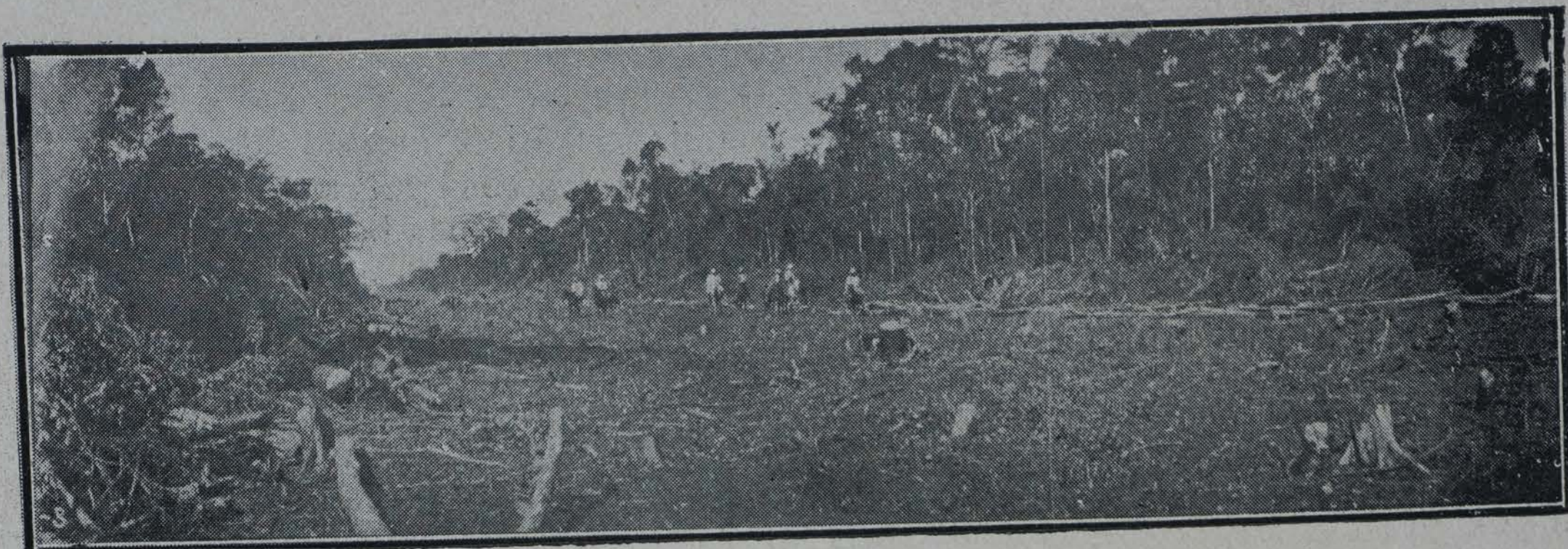
VISITA DE INSPECCIÓN DE LOS TRABAJOS DEL FERROCARRIL
