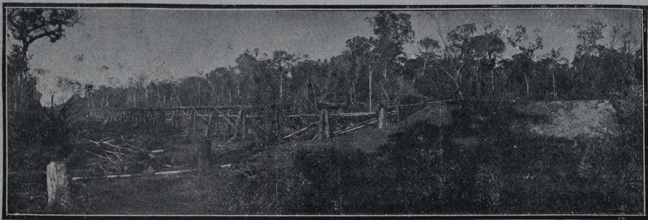
PUENTE PROVISIONAL PARA LA CONSTRUCCIÓN DEL CAMINO CENTRAL
